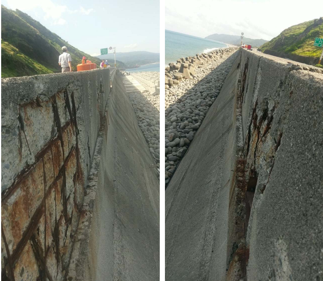
圖 3.29 南興段(440K+900)水泥護欄受波浪衝擊剝落情形，左圖為向北拍攝，右圖為向南拍攝
