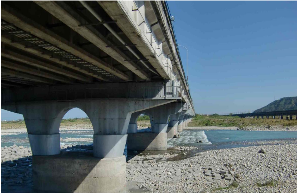
圖 5.3 大甲溪橋現況鼎形塊排置工法
