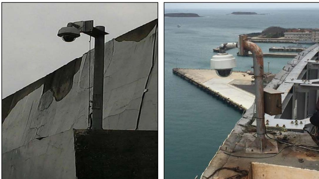
圖 3-71 綠島攝影機(支撑架锈蝕)      圖 3-72 澎湖(支撑架锈蝕)
