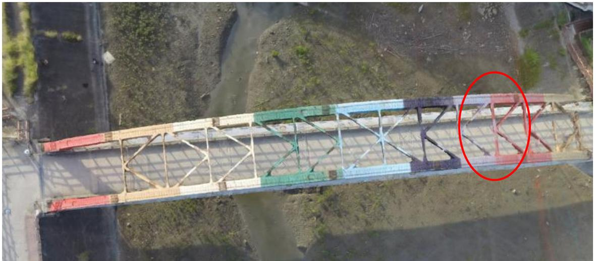
圖 3.19b 以 UAV 拍攝彩虹二橋橋頂鏽蝕原始照片生成 3D 模型
