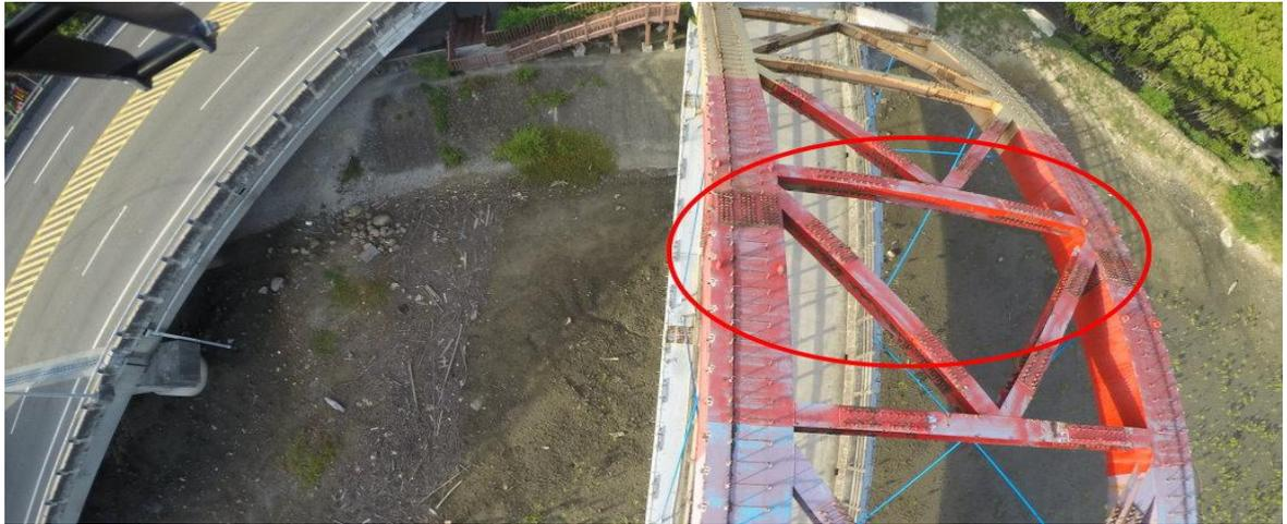
圖 3.19a 以 UAV 拍攝彩虹二橋橋頂鏽蝕原始照片
