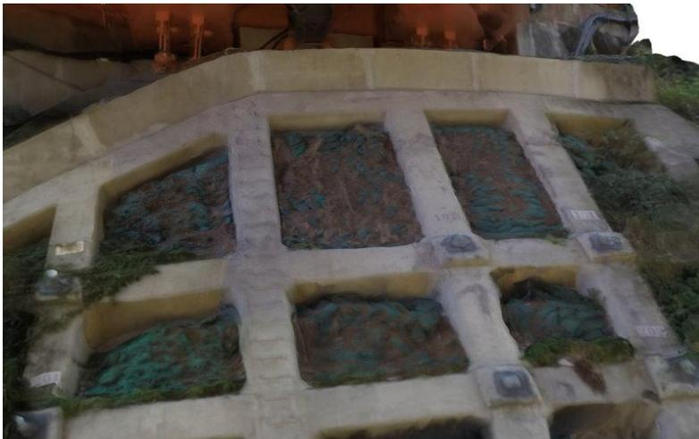
圖 3.20b 以 UAV 拍攝蘇樂橋橋台原始照片生成 3D 模型
