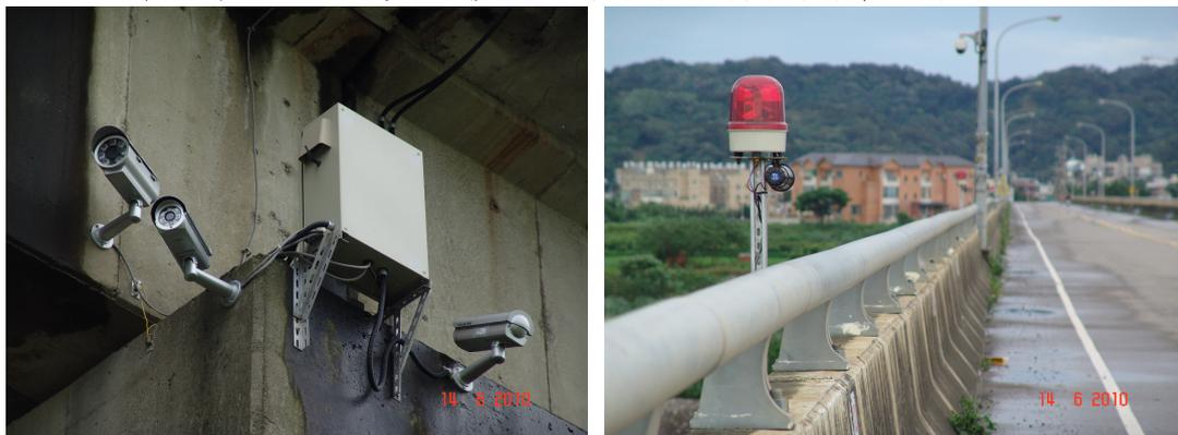
圖 2.12 中正大橋上之監測預警系統(2010 年)
