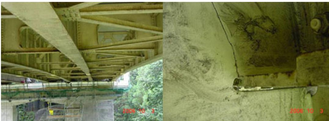
圖 2.14 山添橋的主梁產生裂縫的狀況
