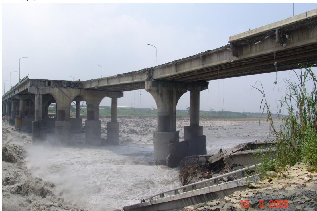
圖 2.10 后豐大橋斷裂(2008 年)
