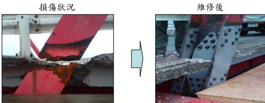
圖 2.15 木曾川大橋的斜撐構件斷裂狀況
