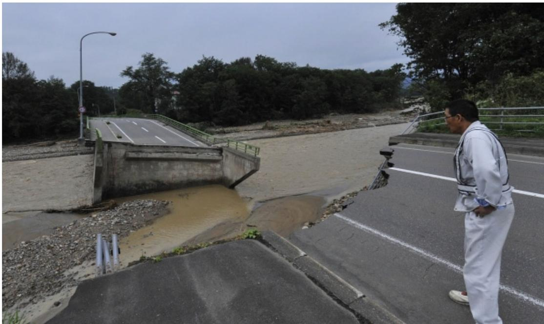
圖 2.17 北海道芽室町上美生橋因洪水影響崩塌的情形
