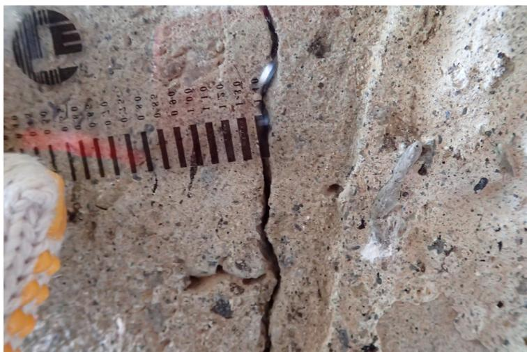
圖 5.10 舊路村十一鄰橋 A1 橋台裂縫寬度量測
