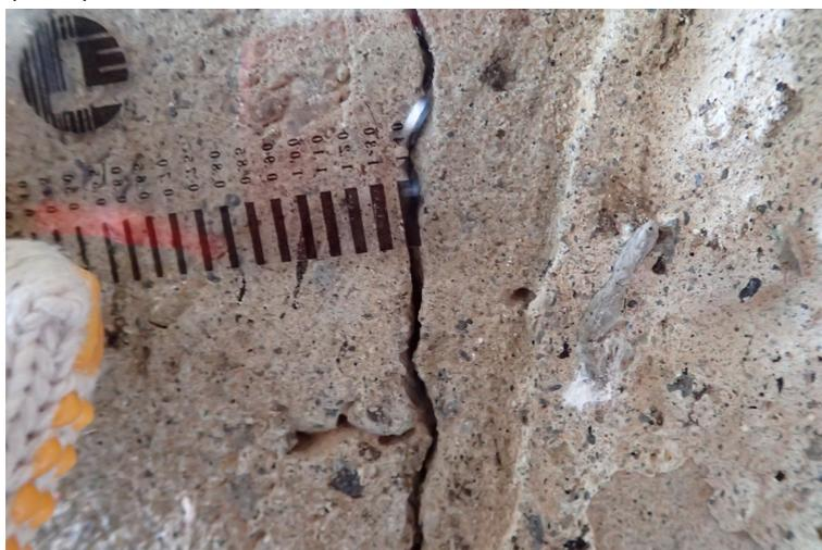
圖 5.2 以裂縫尺量測裂縫寬度
