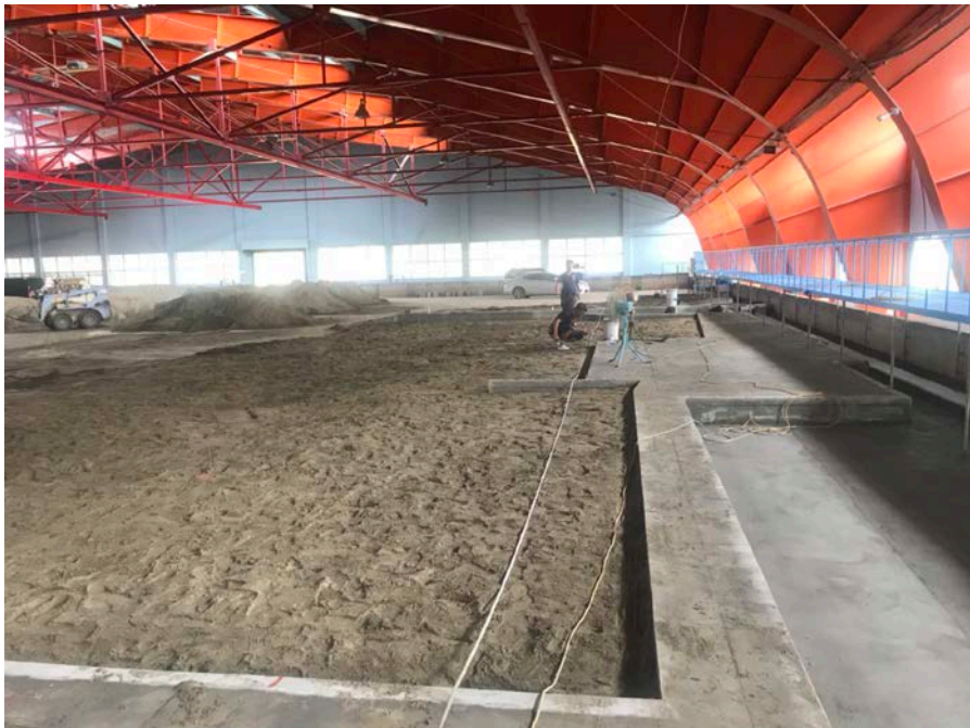
圖 2.22 模型施作之地形鋪設
