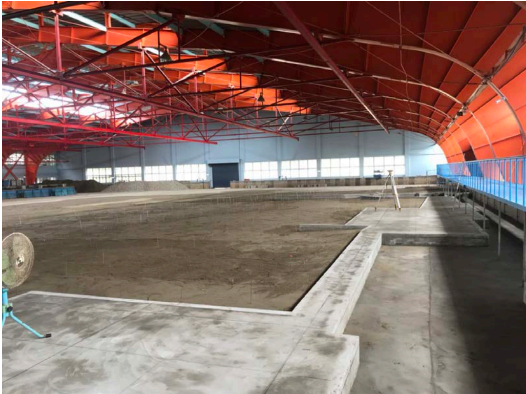
圖 2.23 完成試驗之現場地形鋪設
