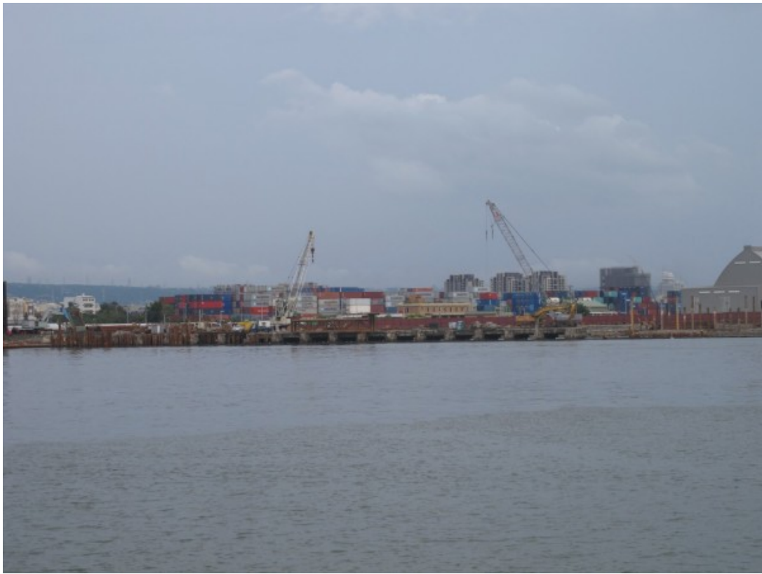
圖 4.4 臺中港 5A 及 5B 重件碼頭(碼頭承載力 50 噸/m 2 )
