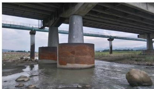
臺3線南雲大橋14號橋墩
