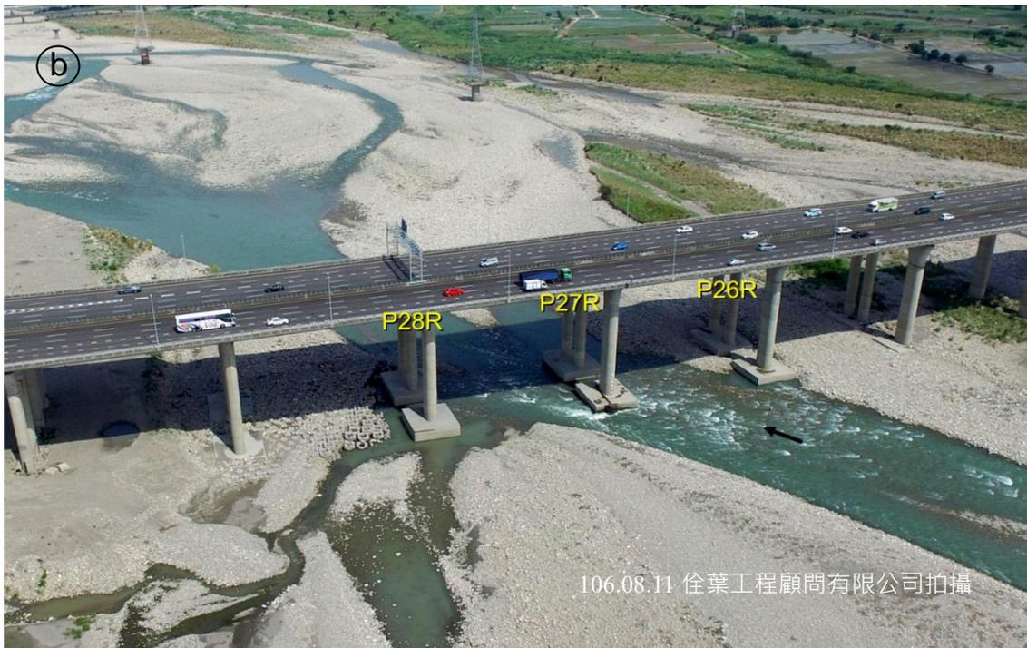
**圖 2.5 國 3 大甲溪橋(P27R 及 P28R)上下游橋基樁帽裸露狀況**
