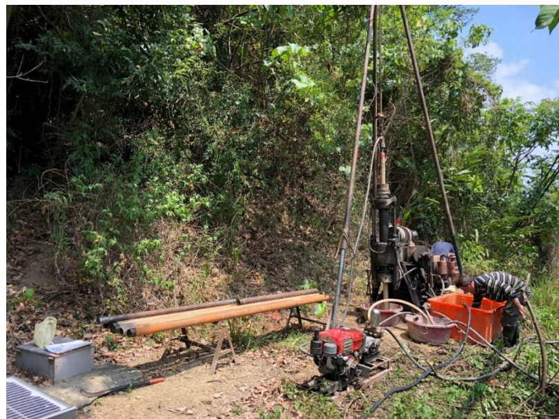
圖 5.4 道路上邊坡鑽探施工情形
