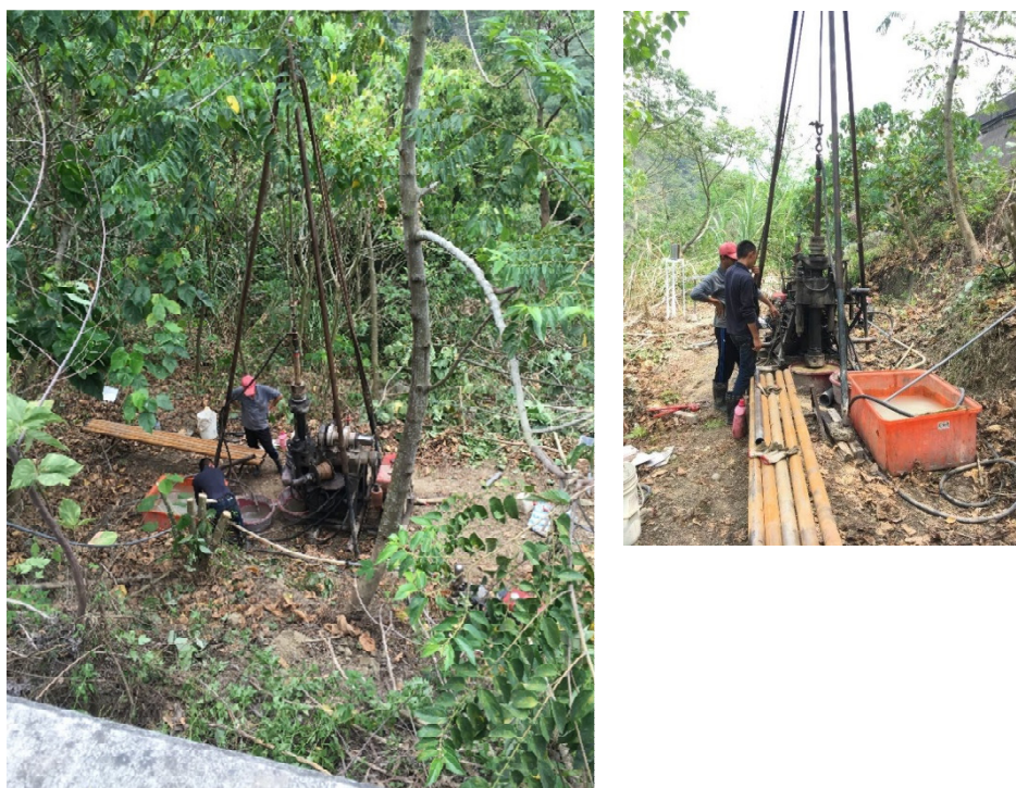
圖 5.5 道路下邊坡鑽探施工情形
