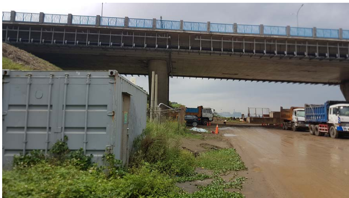
圖3.6 臺北港雷達南側測站設置現場
