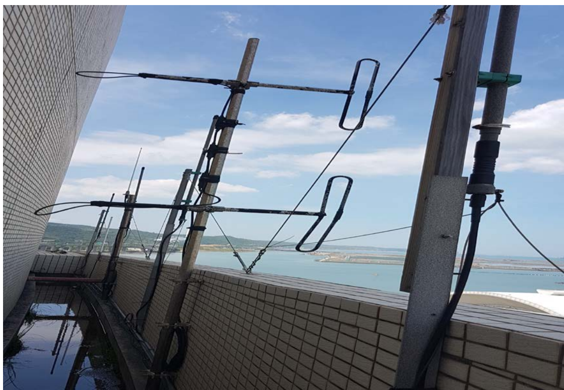
圖3.5 臺北港雷達北側測站接收天線
