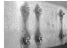
不同腐蝕電位之金屬接觸造成之電偶腐蝕
