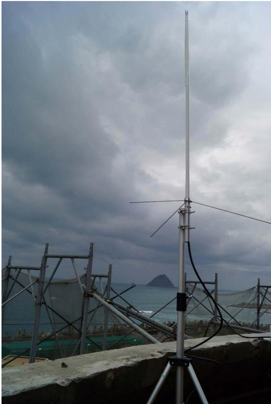
**圖 6.19 航管中心 AIS 中繼接收端天線實體**
