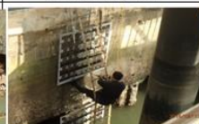
飛沫帶試驗架自動鎖安裝
