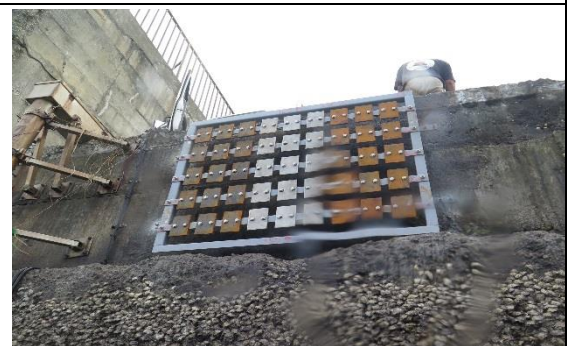
8.花蓮港試驗架安裝完成
