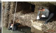
潛水員清除岸壁面海附生物
