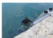
金屬腐蝕試驗架安裝
