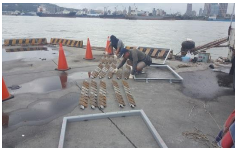
3.金屬腐蝕試驗架安裝
