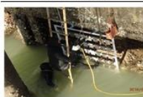
潮沙帶試驗架自動鎖安裝
