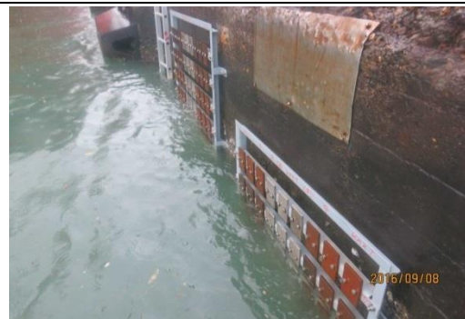
8.高雄港#40 試驗架安裝完成
