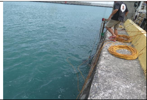
2.潛水員清除岸壁面海附生物
