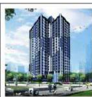
「勝勝市中欣」A7樓上頂樓，屋頂綠意高約1-1.5米，綠意盎然。
