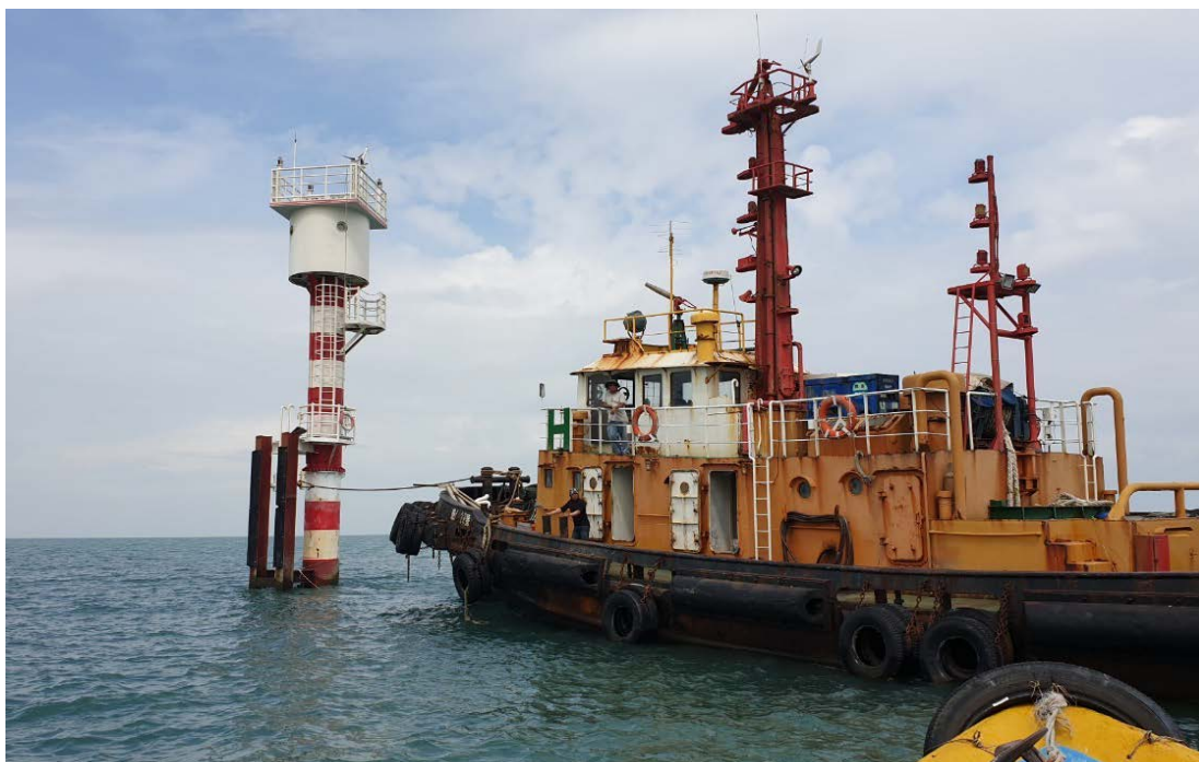
圖 13 臺中樁打設完成圖
