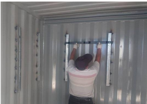
(g)儀器固定架施工
