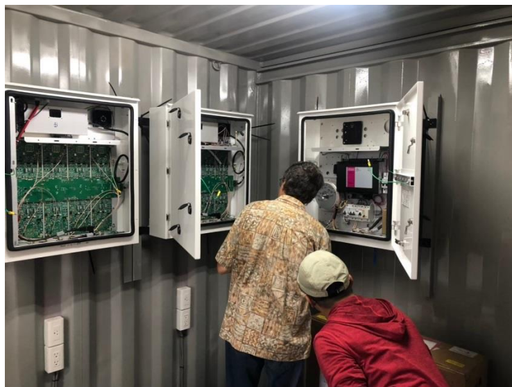
圖 4.11 雷達系統的安裝與調整
