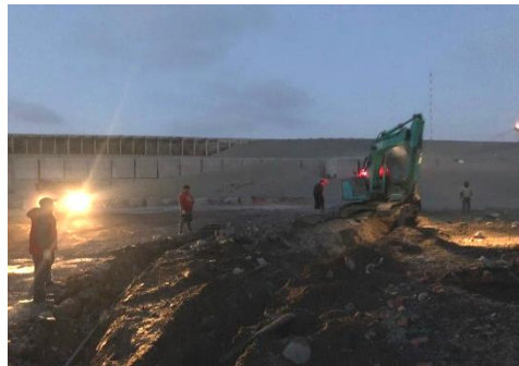
(d)管溝開挖
