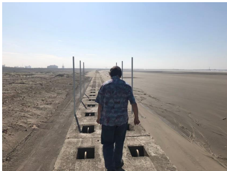
圖 4.12 雷達發射天線的安裝確認
