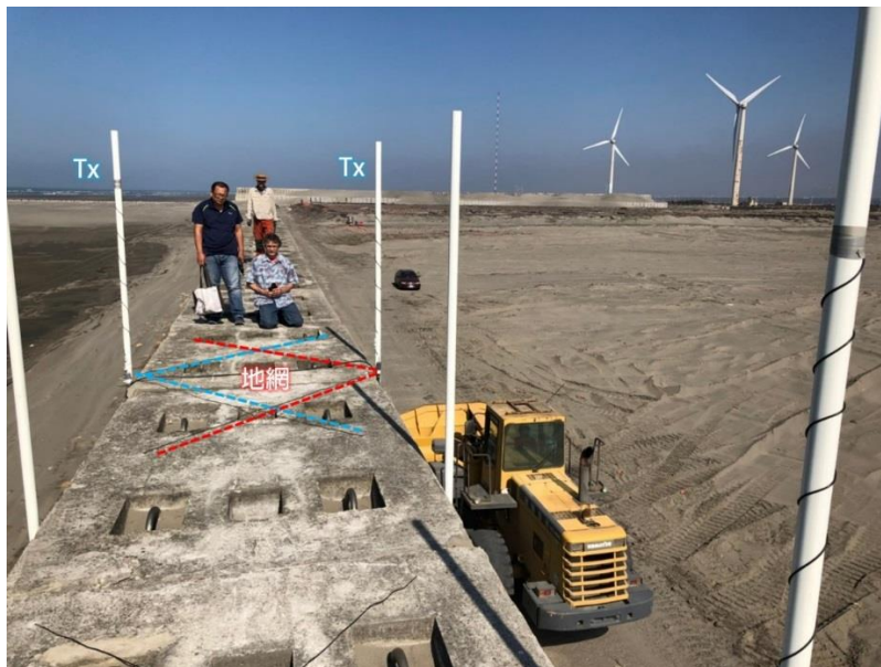
圖 4.15 本雷達設置地網之情形
