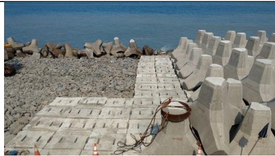
設置開孔塊石與堤心石 (運研所李俊穎科長提供)
