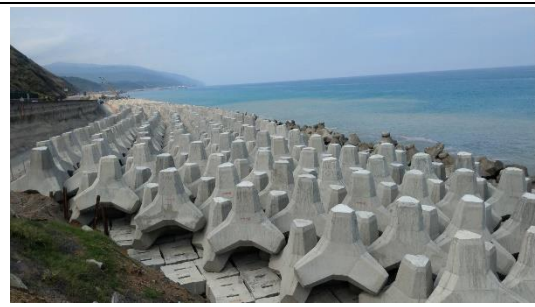
消波塊鋪設 (運研所李俊穎科長提供)
