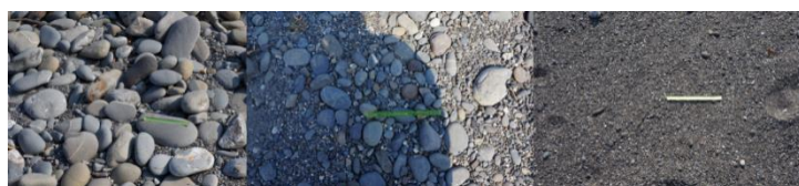
圖 2.1.6 臺東大武漁港南側利用草埔隧道開挖之砂石進行養灘
