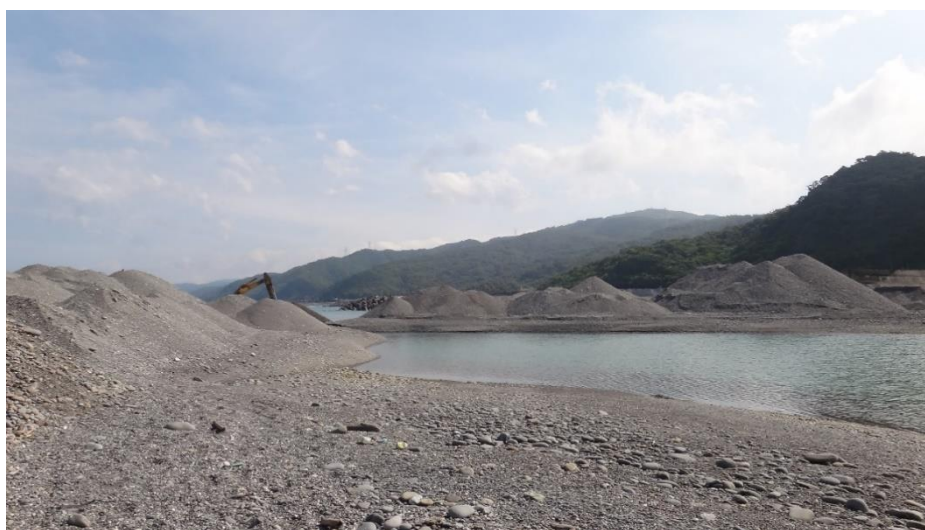
圖 2.1.14 臺東大武漁港航道淤積嚴重，長年需挖掘淤積砂石
