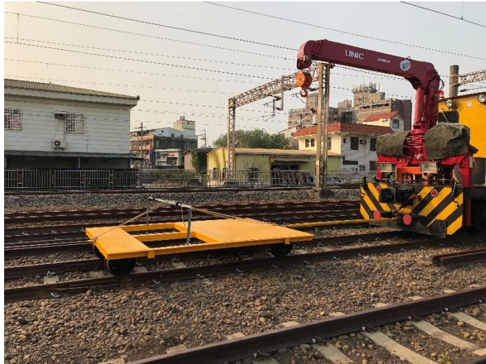
圖 3.15 平車組裝完成照片
