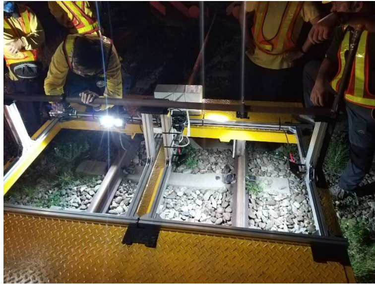
圖 4.7 調整夜間實測照明設備位置
