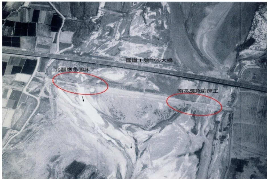
圖 4.4 中沙大橋下游固床工
