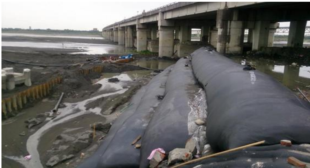
圖 4.9 中沙大橋橋基高灘地之沙腸管施作情形
