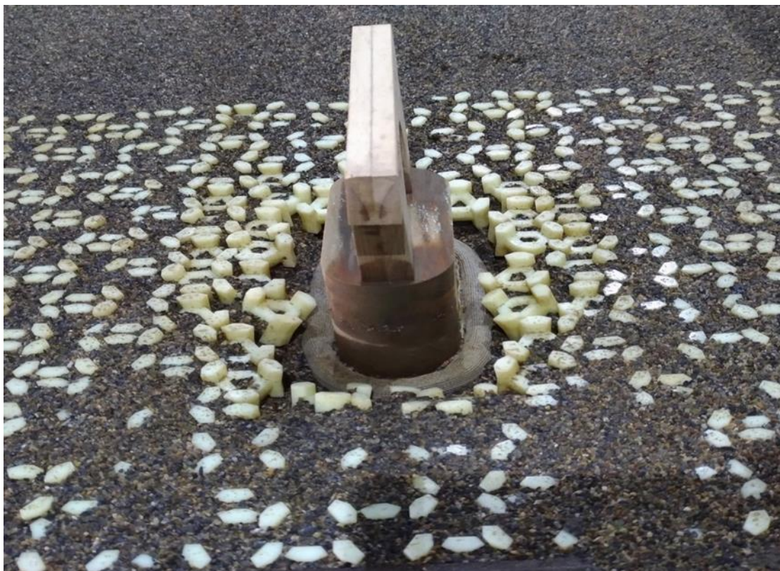
圖 2.17 蛇籠+織物模板+鼎型塊基礎沖刷情形
