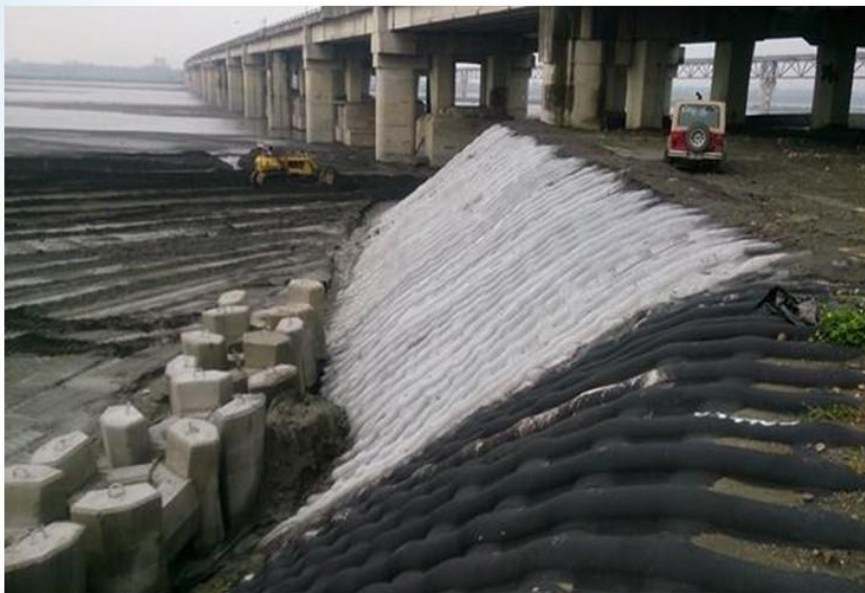
中沙大橋橋基高灘地之織物模板施作情形
