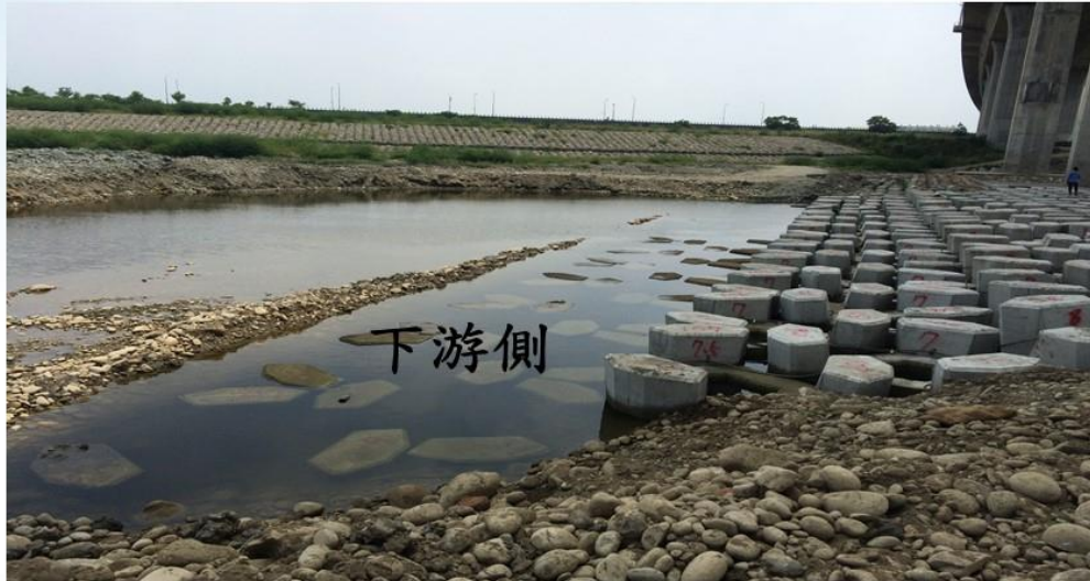
國道3號後龍溪橋鼎型塊降階鋪設減緩下游側的水力坡降
