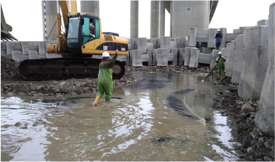
圖 5.12 上游織布回包錨定作業
