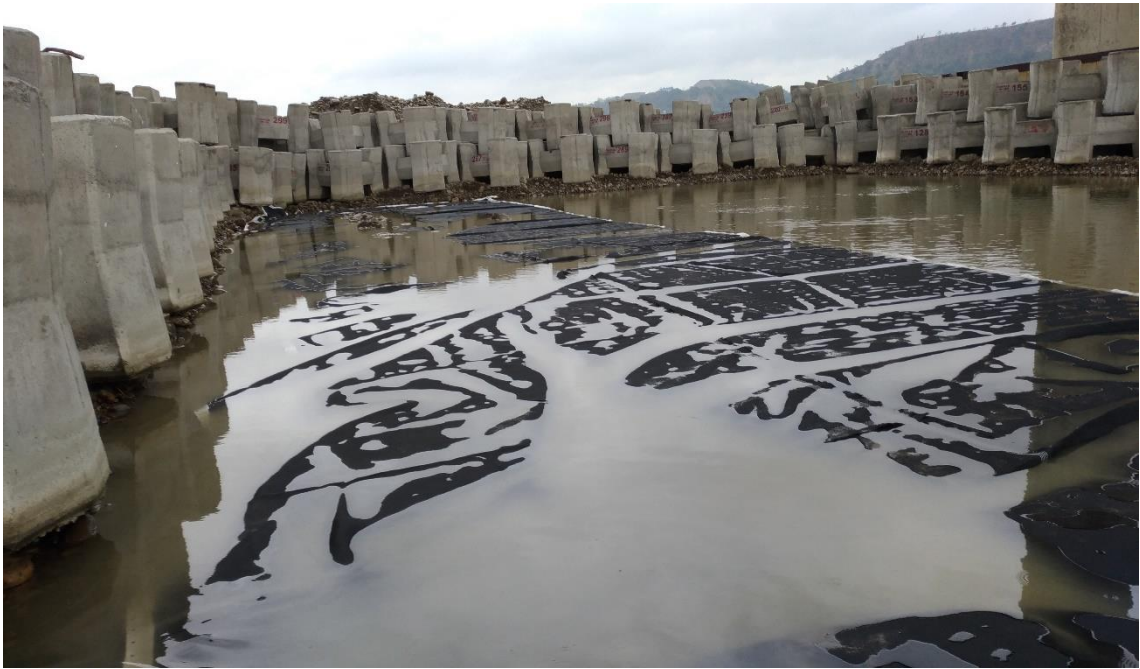
圖 5.10 挖土機協助將第一單元的織布拖放至定位並輔以人工整平
