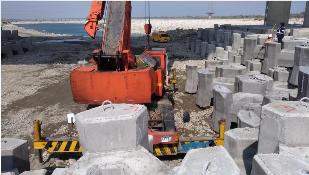
回填後鼎塊吊放
