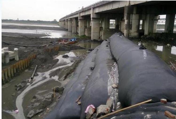
中沙大橋橋基高灘地之沙腸管施作情形
