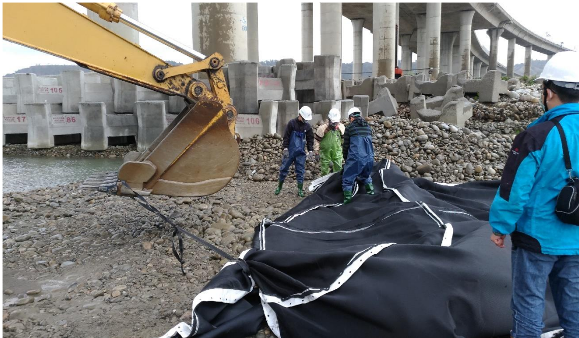
圖 5.9 挖土機協助將織布從載運之卡車卸下並於現地展開
