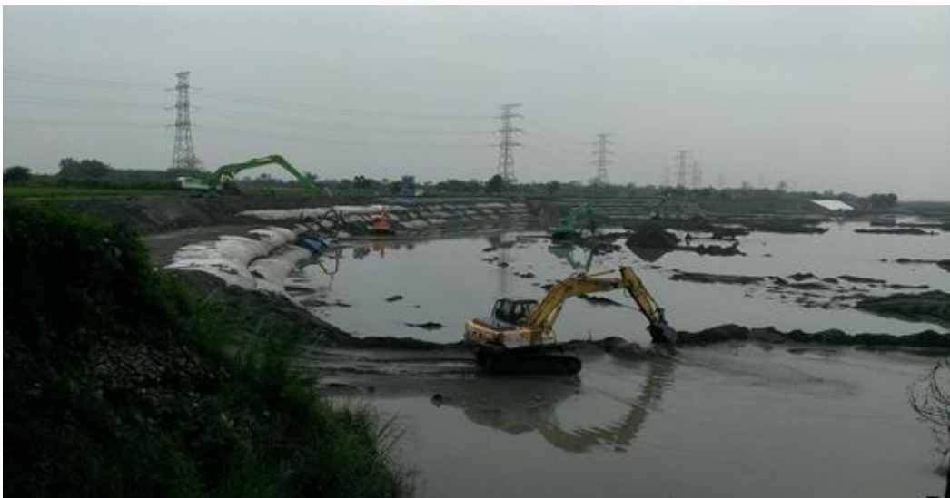
圖 4.7 四河局於中沙大橋上游高灘地之保護工施作情形
