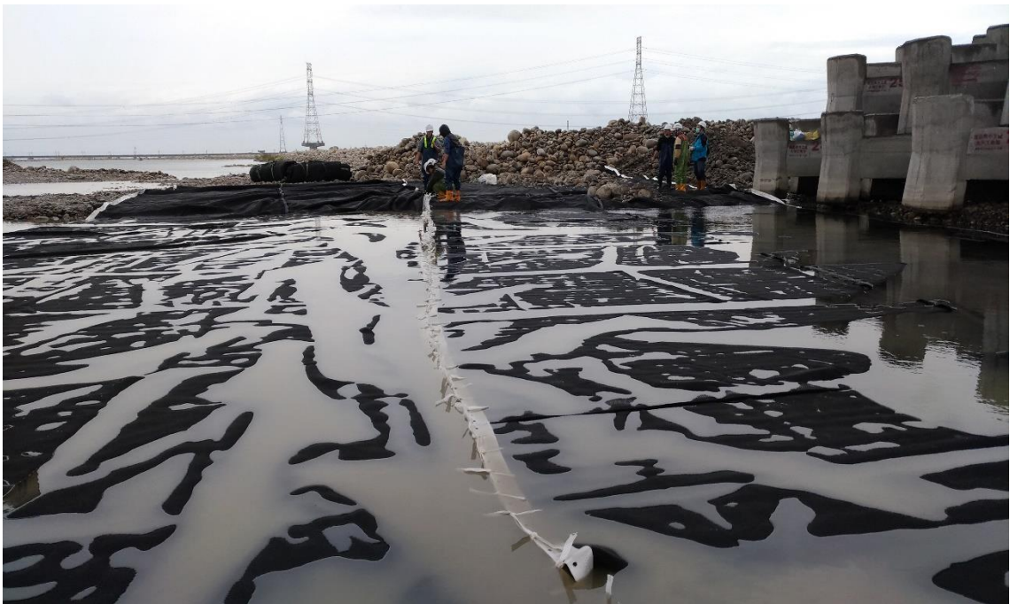
圖 5.10 挖土機協助將第一單元的織布拖放至定位並輔以人工整平
