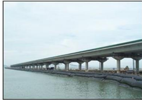
韓國仁川跨海大橋橋墩保護應用案例(砂腸管)
