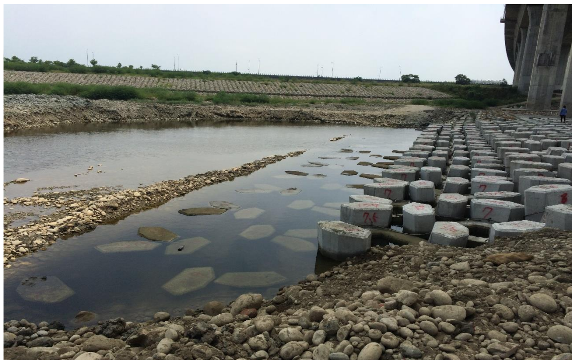
圖 6.2 國道 3 號後龍溪橋鼎型塊降階排置下游面
