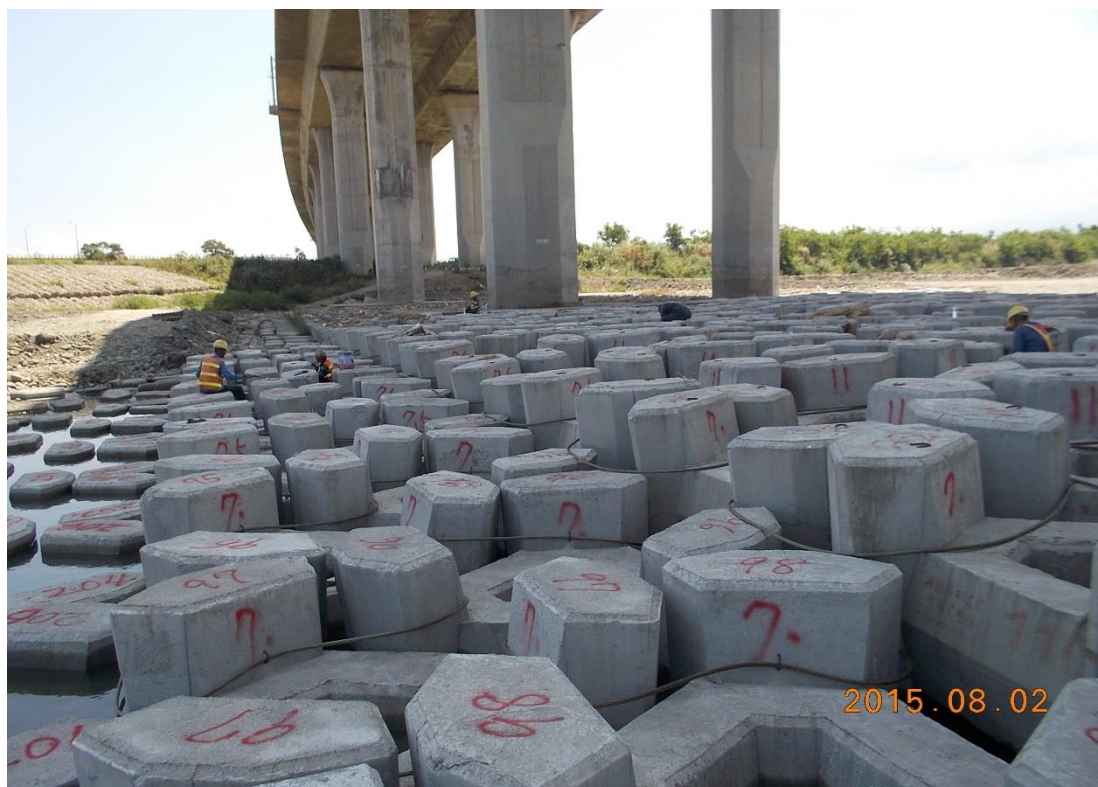
圖 6.1 國道 3 號後龍溪橋鼎型塊降階排置上游面
