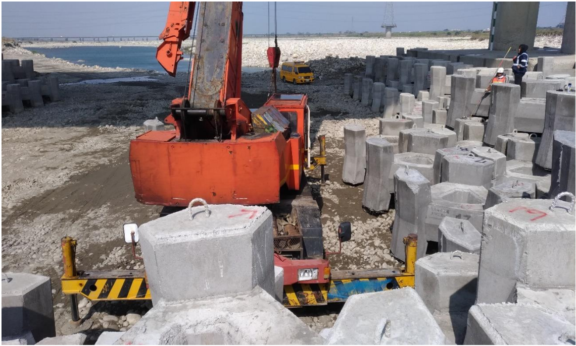
圖 5.14 鼎塊吊放排置作業
