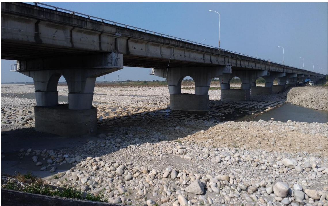
圖 6.7 台 1 線大甲溪橋
