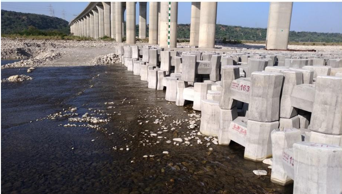
鼎塊吊放作業完成下游面
