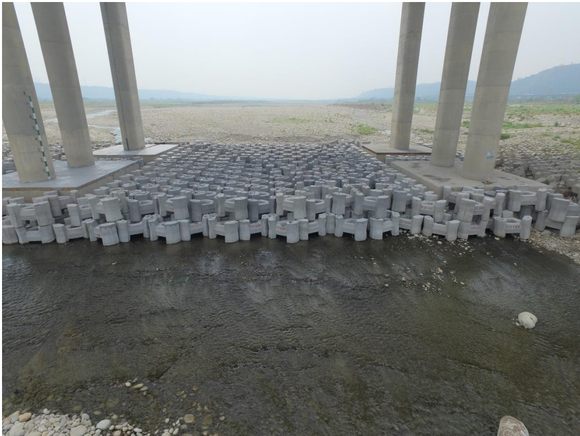
圖 5.15 鼎塊吊放排置完成下游側
