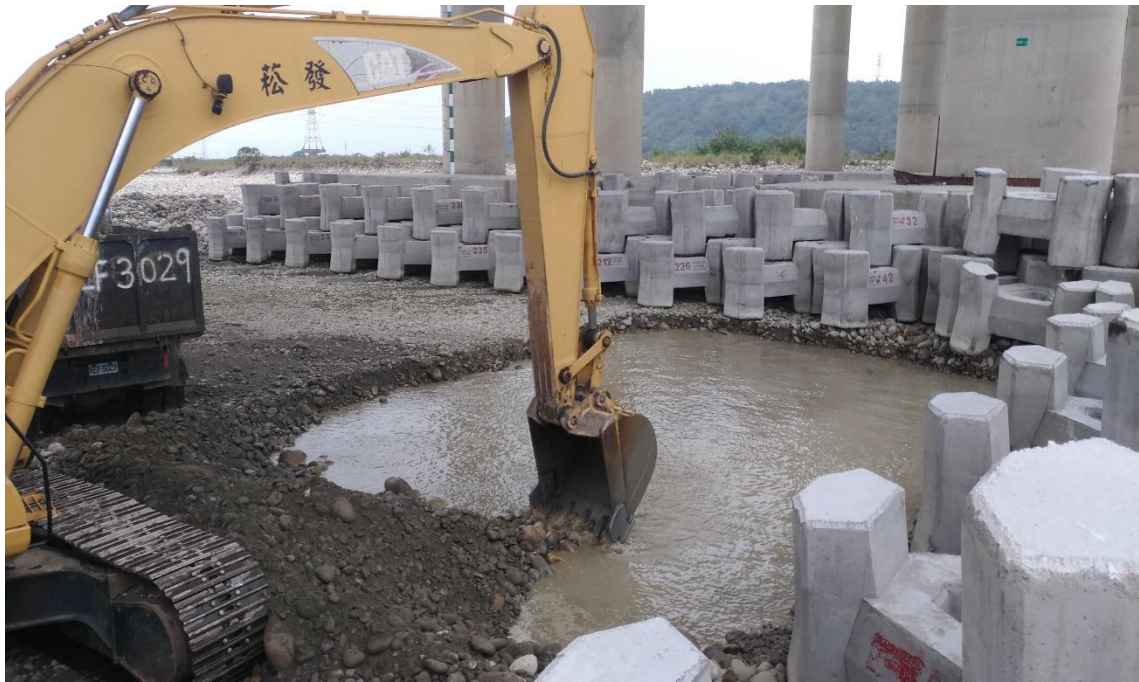
圖 5.8 開挖現地河床面
