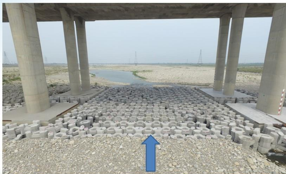
民國107年深槽區橋墩及保護工
