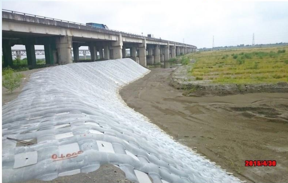
中沙大橋橋基高灘地保護工成效
