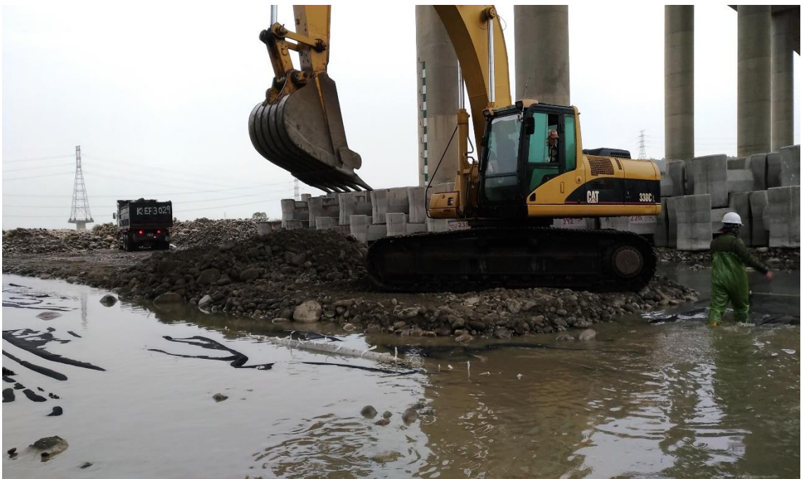
圖 5.13 織布上層粒料回鋪作業
