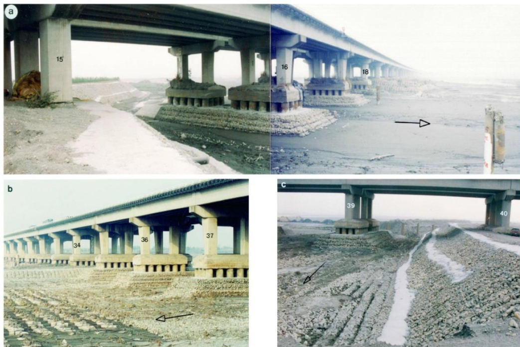
圖 4.3 中沙大橋橋墩保護工
