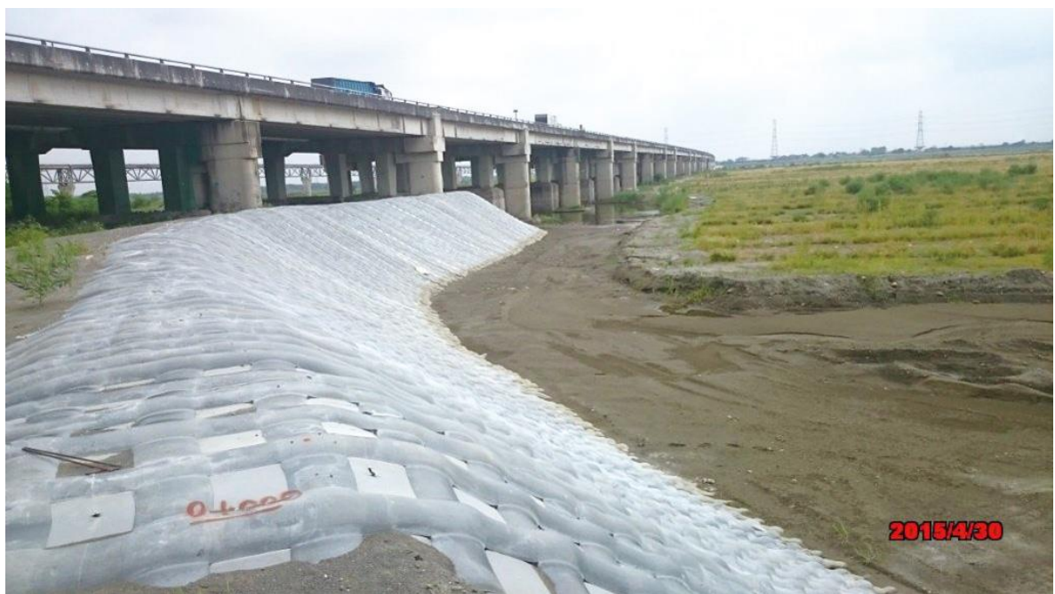
圖 4.11 中沙大橋橋基高灘地保護工成效
