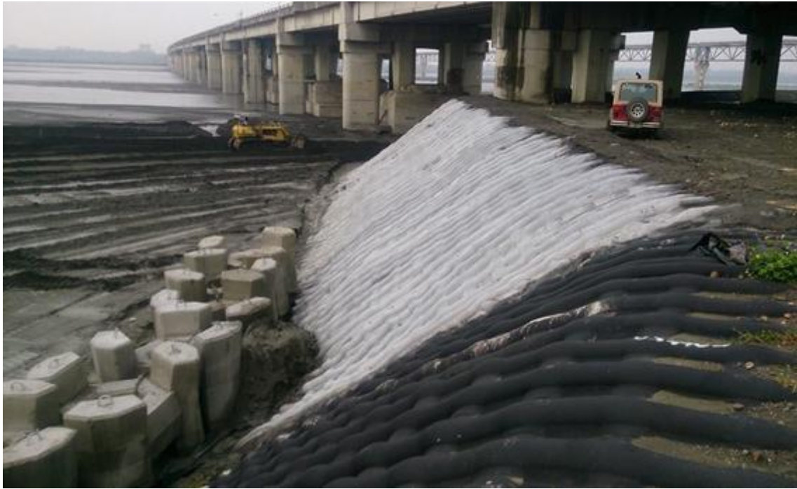
圖 4.10 中沙大橋橋基高灘地之織物模板施作情形
