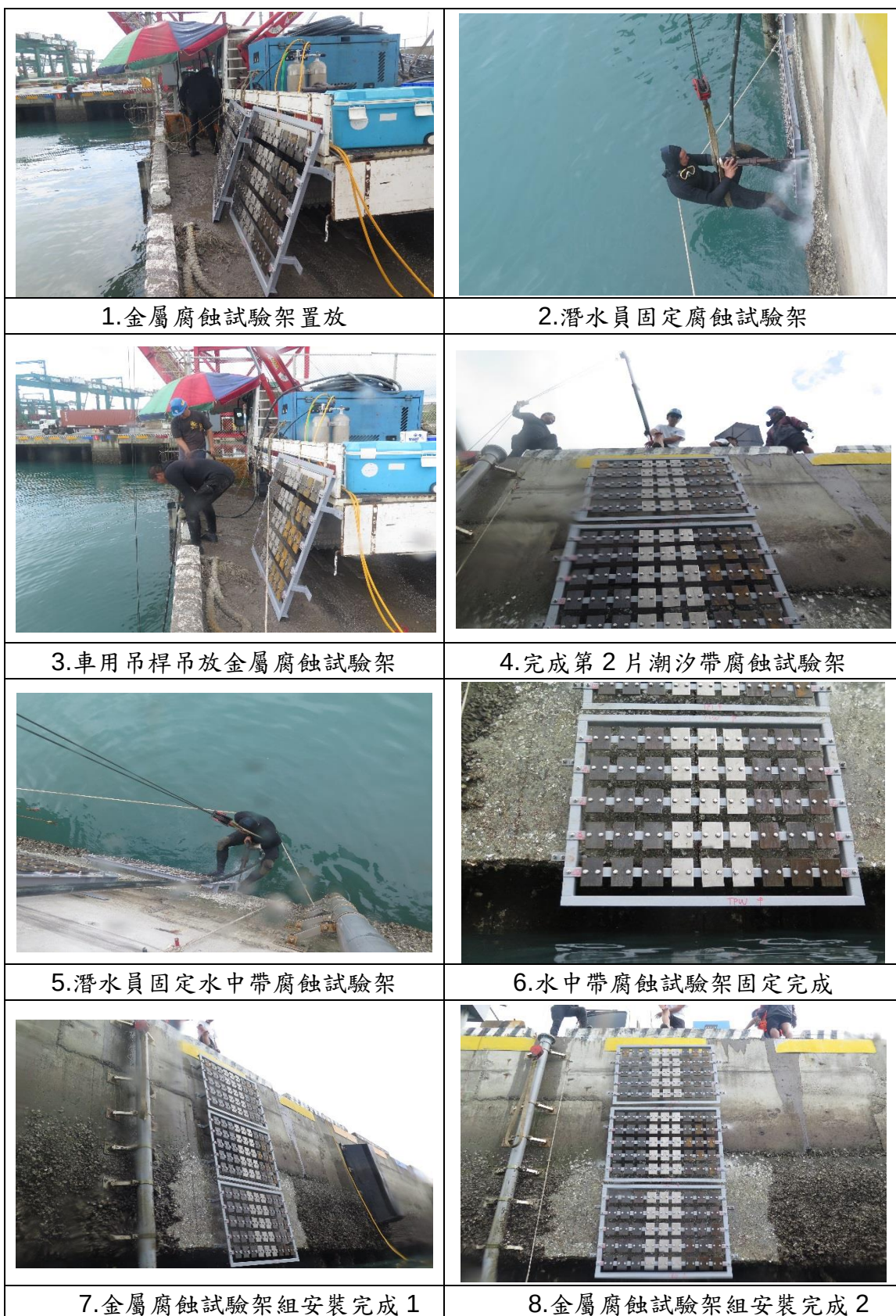
圖 3.4 臺北港水下金屬暴露試驗架安裝
