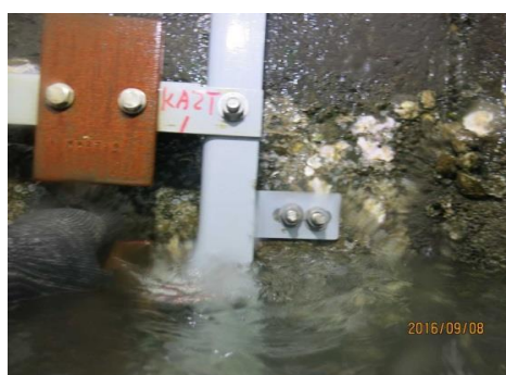
6.潮汐帶試驗架安裝完成
