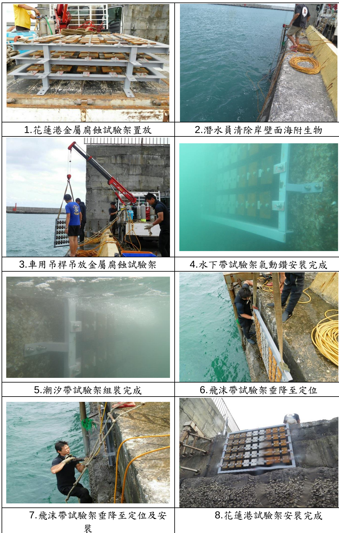
圖 3.6 花蓮港水下金屬暴露試驗架安裝
