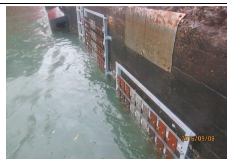
8.高雄港 40 號碼頭試驗架安裝完成
