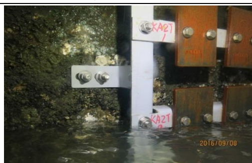
7.潮汐帶試驗架安裝完成
