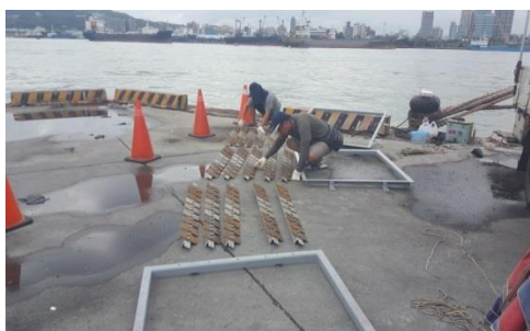
3.金屬腐蝕試驗架安裝
