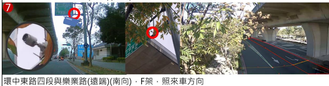
圖 4.2.4 環中東路四段與樂業路口(紅 2、3、5、7) 偵測設備架設位置與畫面
