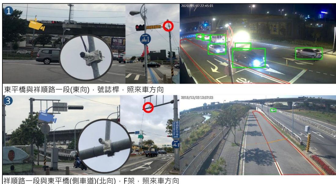
圖 4.2.6 東平橋與祥順路口(藍 1、3)偵測設備架設位置與畫面
