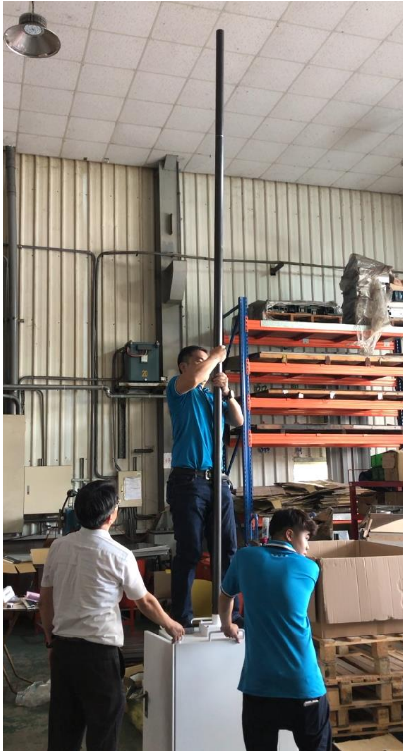
圖 3.2.5 臨時性設備攝影機固定桿裝卸操作
