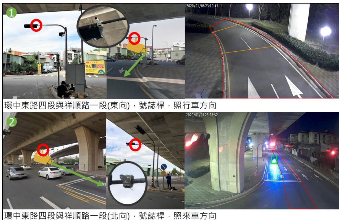
圖 4.2.9 環中東路四段與祥順路口(綠 1、2)偵測設備架設位置與畫面
