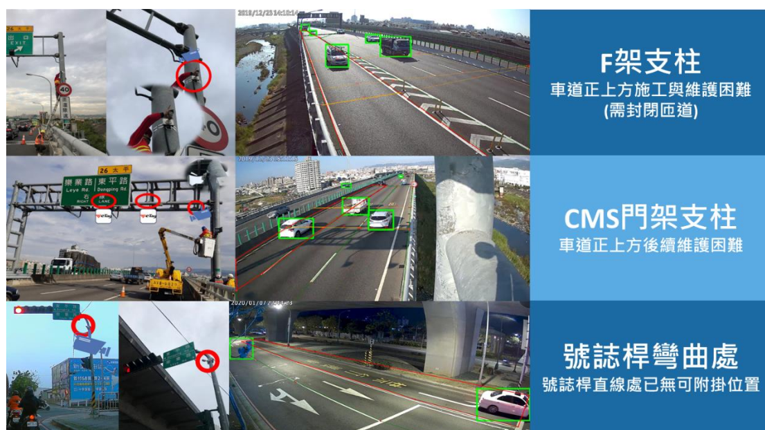
圖 3.1.23 攝影機未於建議位置裝設圖及拍攝狀況
