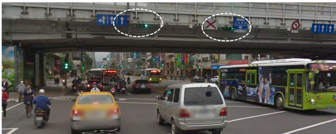
圖 2-6 高架橋增設遠端號誌（臺北市建國南路信義路）
