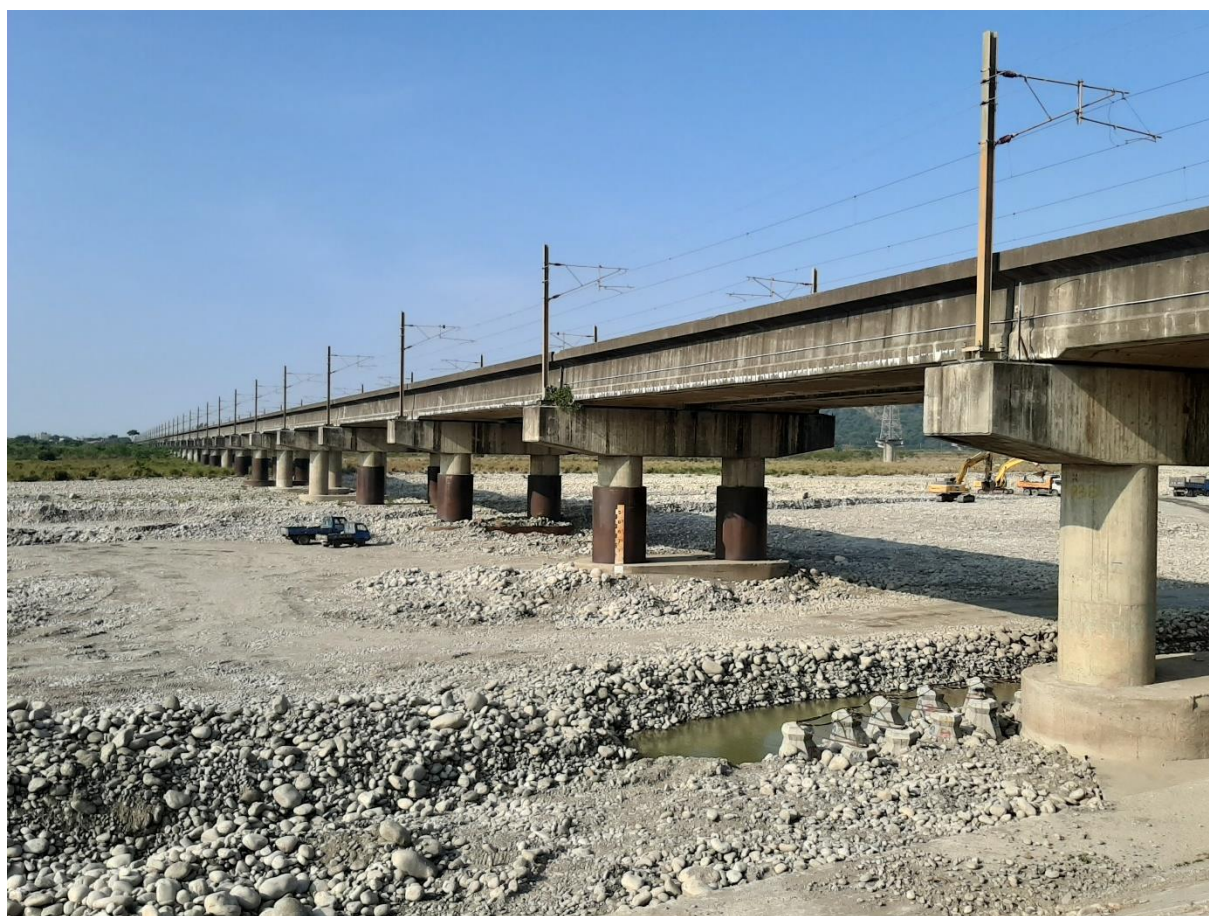
圖 3.3 海線鐵路橋現況
