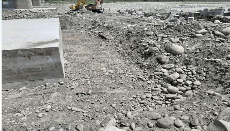
橋墩基礎上游整地
