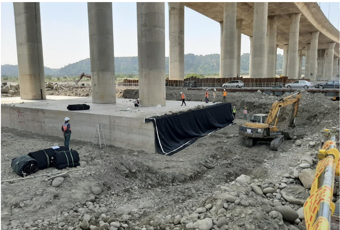
圖 6.13 高強度織布展開並以軟石固定於樁帽上
