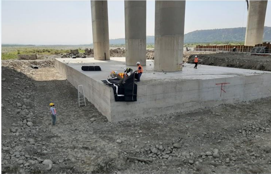
吊放高強度織布於橋墩基礎樁帽上
