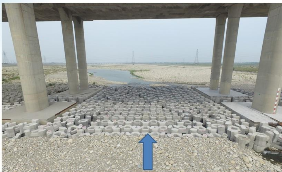
民國107年深槽區橋墩及保護工
