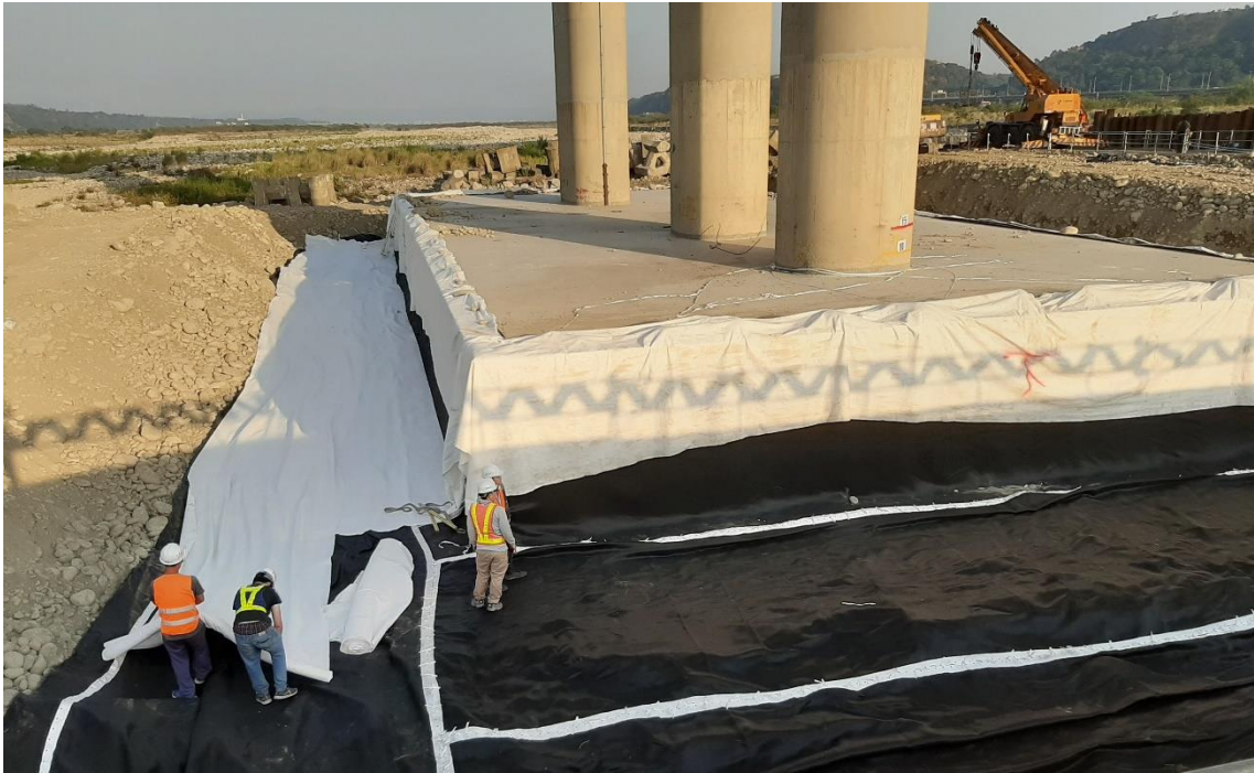
圖 6.16 防護層織布鋪設
