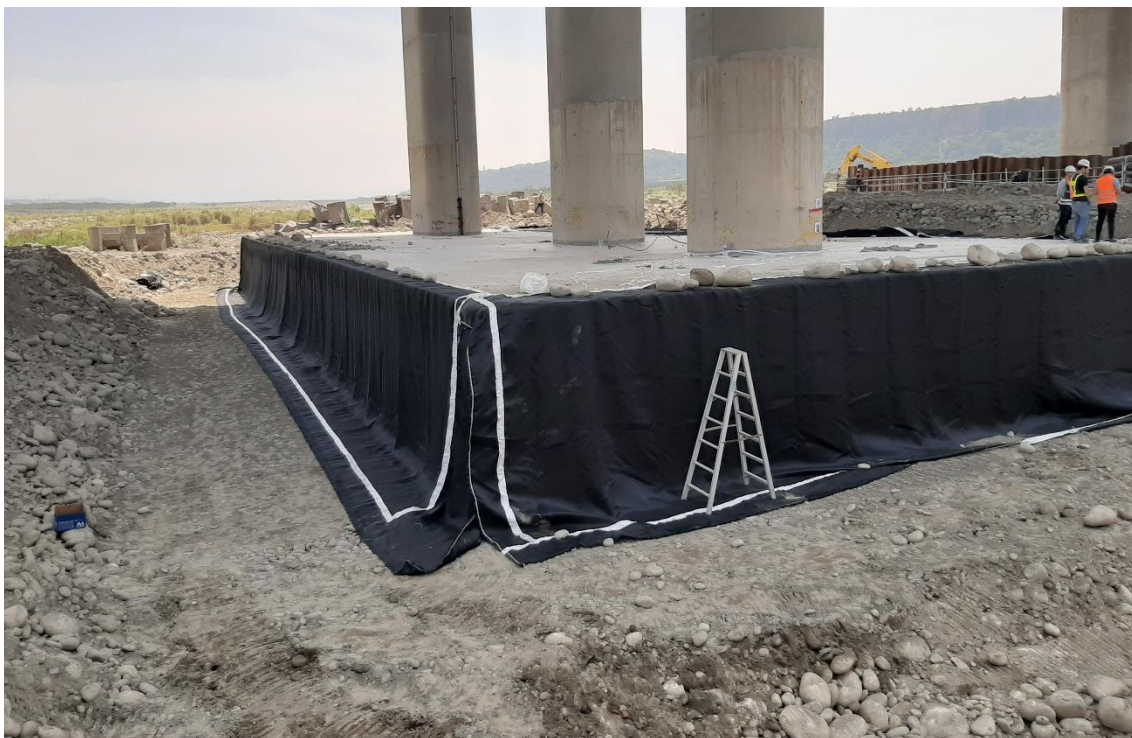
圖 6.14 完成樁帽 4 周之高強度織布吊放展開及固定
