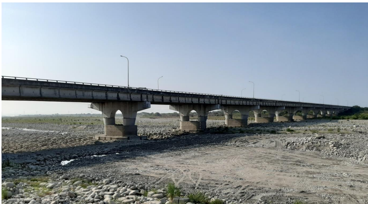
圖 3.4 台 1 線大甲溪橋現況
