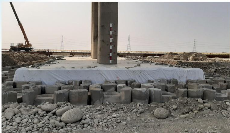
鼎型塊結合地工織布保護工鋪設完成(上游側)
