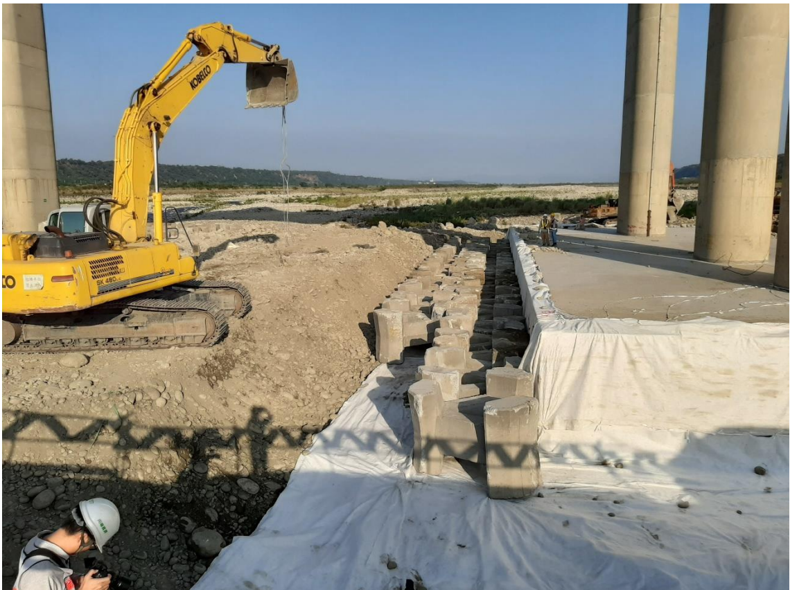
圖 6.19 鼎型塊吊放與排置作業 2
