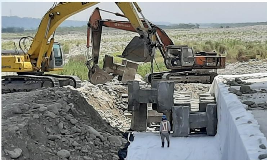
鼎型塊吊放與排置作業
