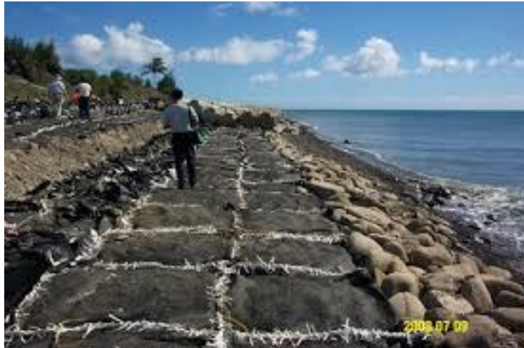
圖 2.4 格網箱籠之海岸保護嘗性大型試驗現場
