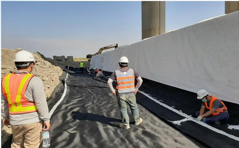
平面織布鋪設及單元間之綁紮作業
