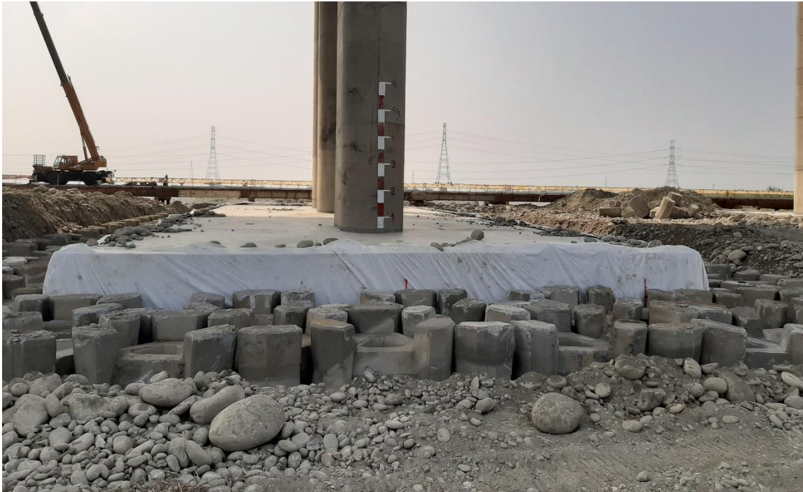
圖 6.20 鼎型塊結合地工織布保護工鋪設完成(上游側)
