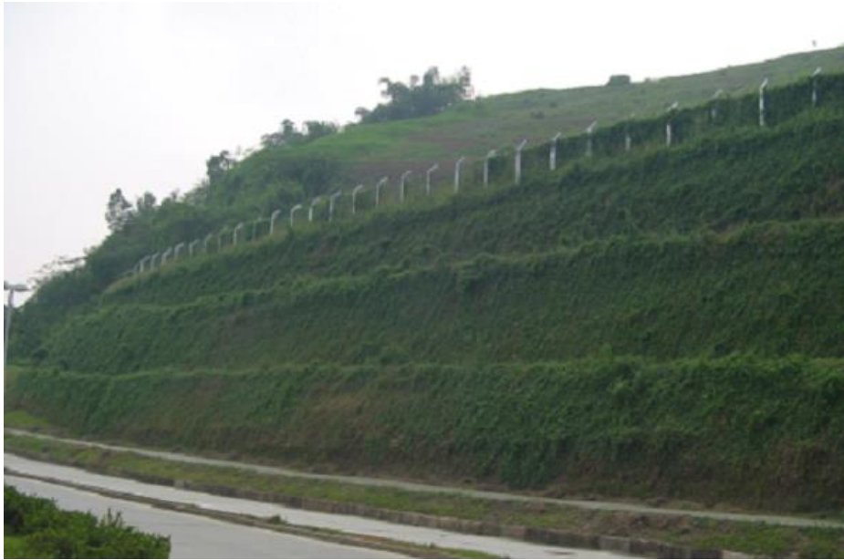
圖 2.2 採用回包式加勁擋土牆之暨南大學邊坡
