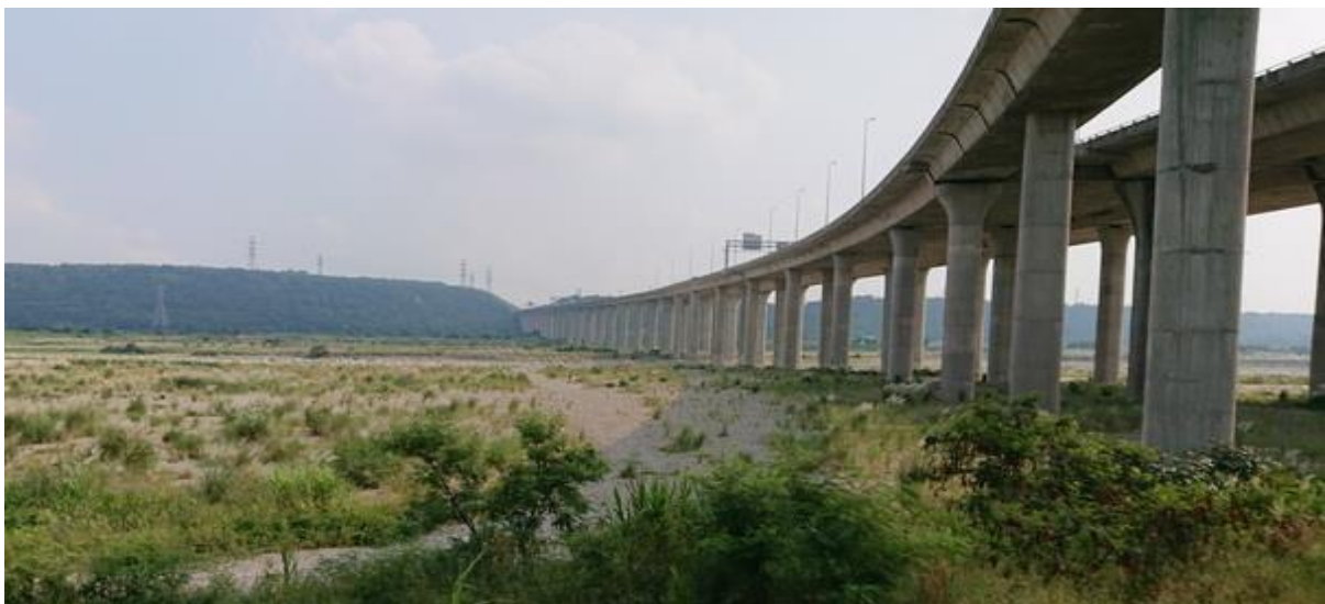
圖 3.2 國道三號大甲溪橋現況
