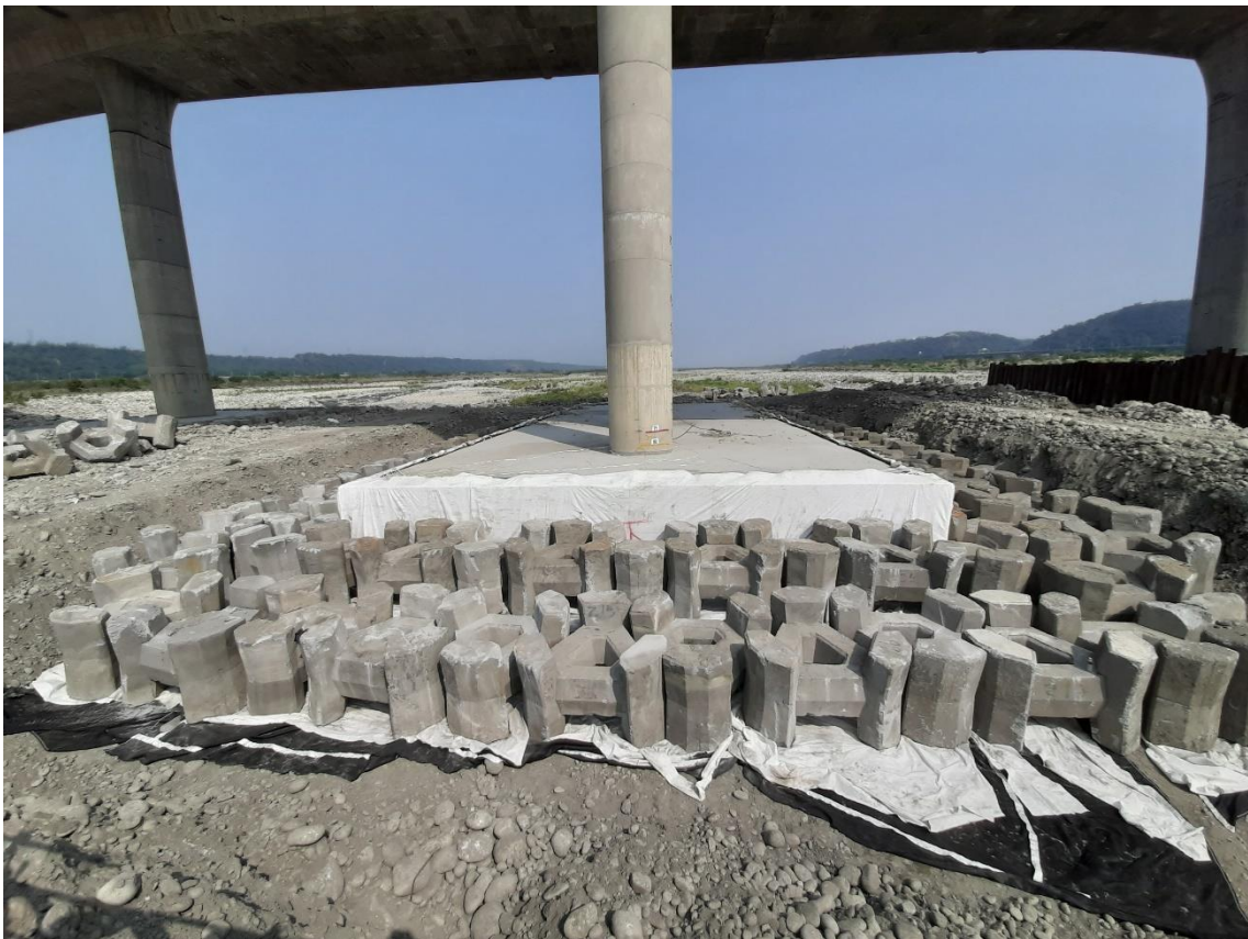
圖 6.21 鼎型塊結合地工織布保護工鋪設完成(下游側)
