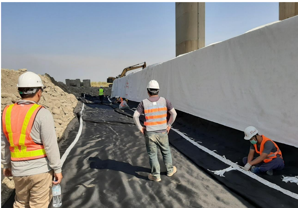
圖 6.15 平面高強度織布鋪設及單元間之綁紮作業
