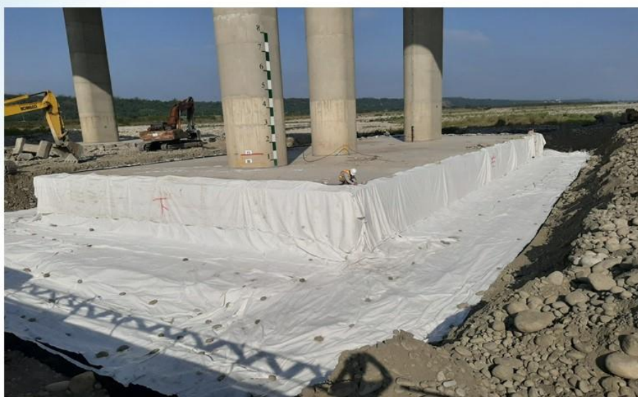
保護層不織布鋪設完成
