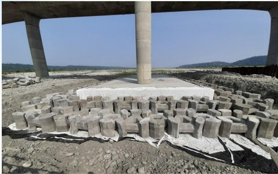
鼎型塊結合地工織布保護工鋪設完成(下游側) 47
