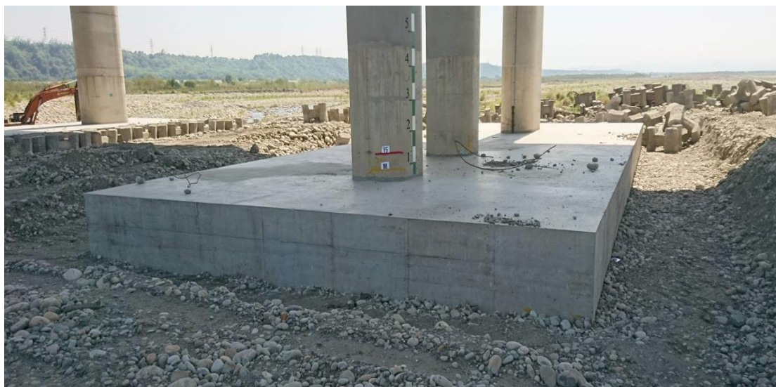
圖 6.9 試驗橋址基礎耐震補強施工後
