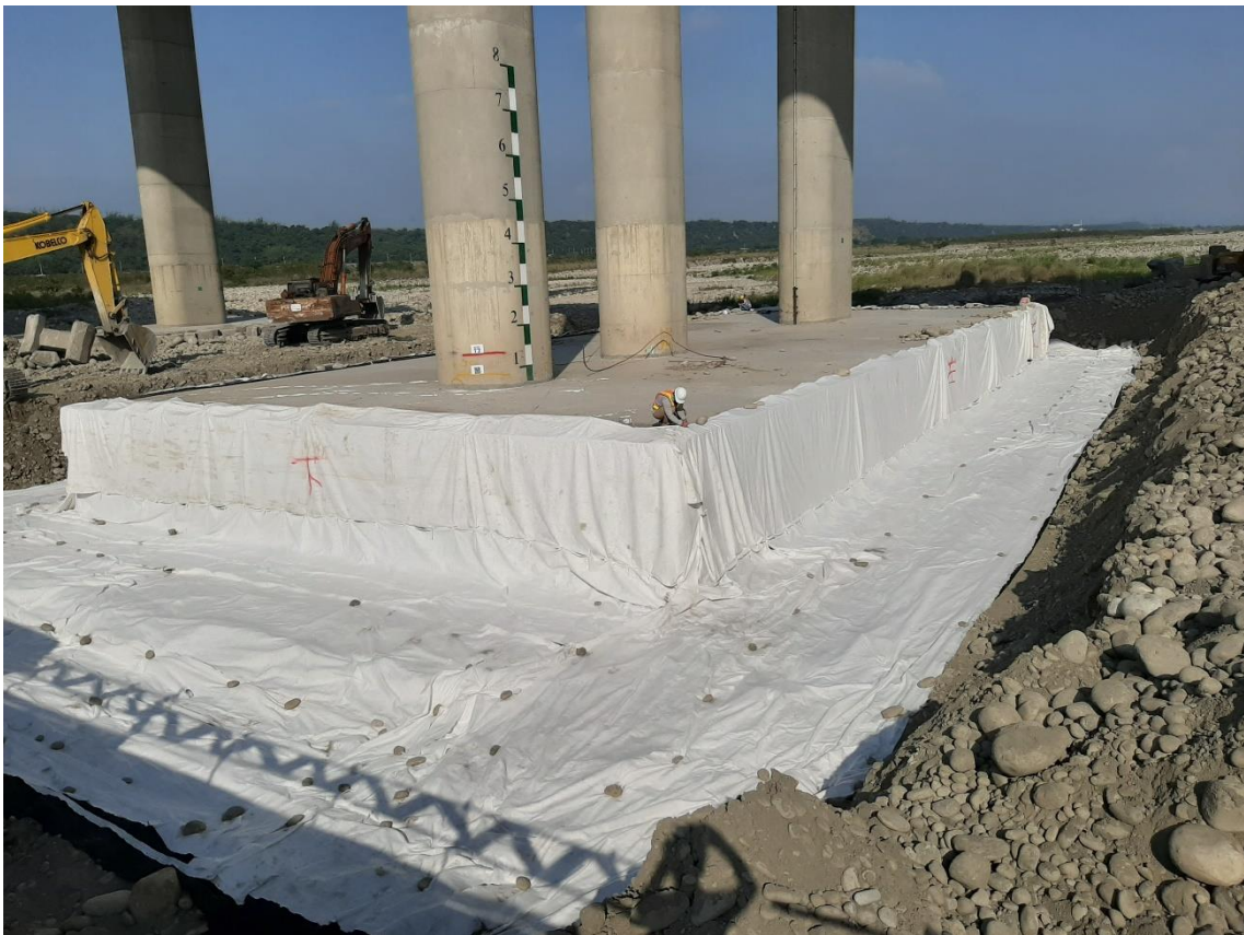
圖 6.17 防護層織布鋪設完成
