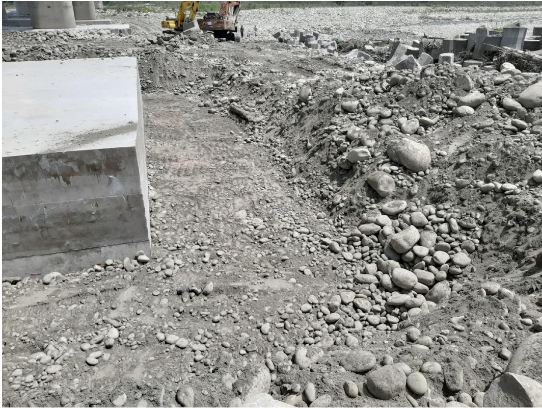
圖 6.10 橋墩基礎上游整地
