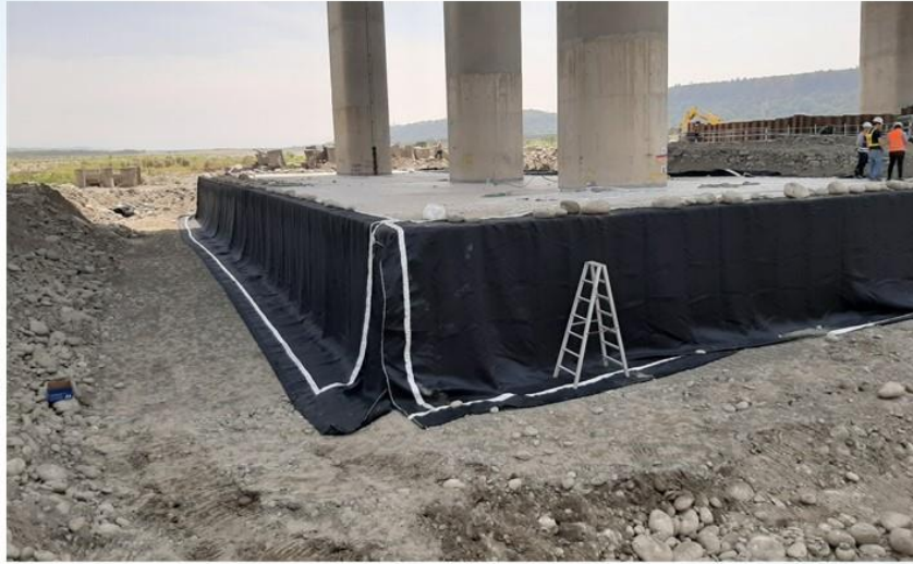
完成樁帽4周之織布吊放展開及固定
