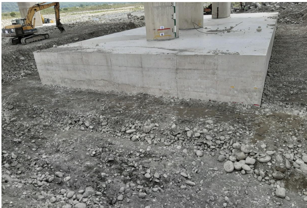
圖 6.11 橋墩基礎下游整地及地形降階
