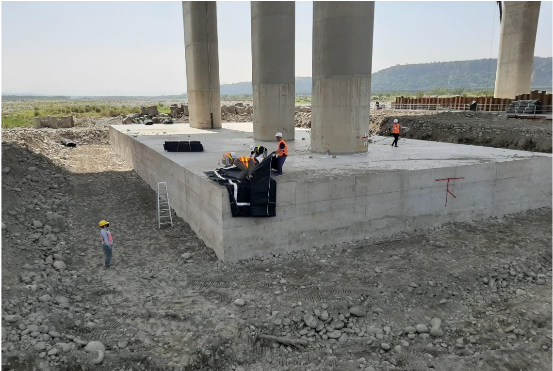
圖 6.12 吊放高強度織布於橋墩基礎樁帽上
