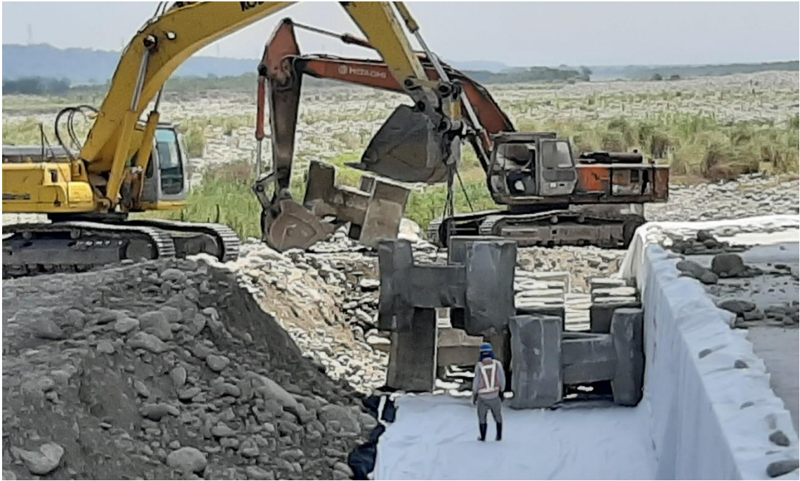
圖 6.18 鼎型塊吊放與排置作業 1
