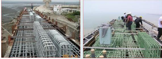
(鍍鋅鋼筋)                      (環氧樹脂鋼筋)
