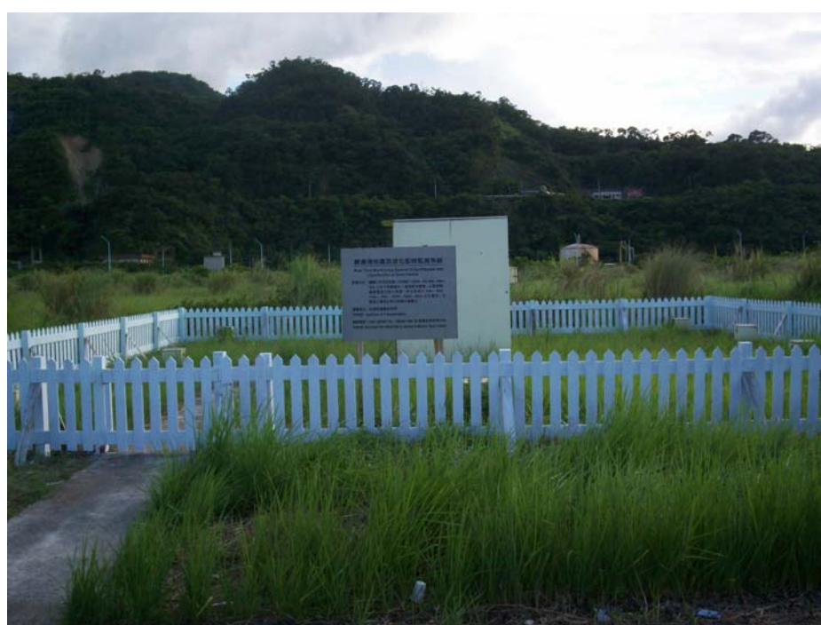
圖 2.12 蘇澳港區井下地震監測站
