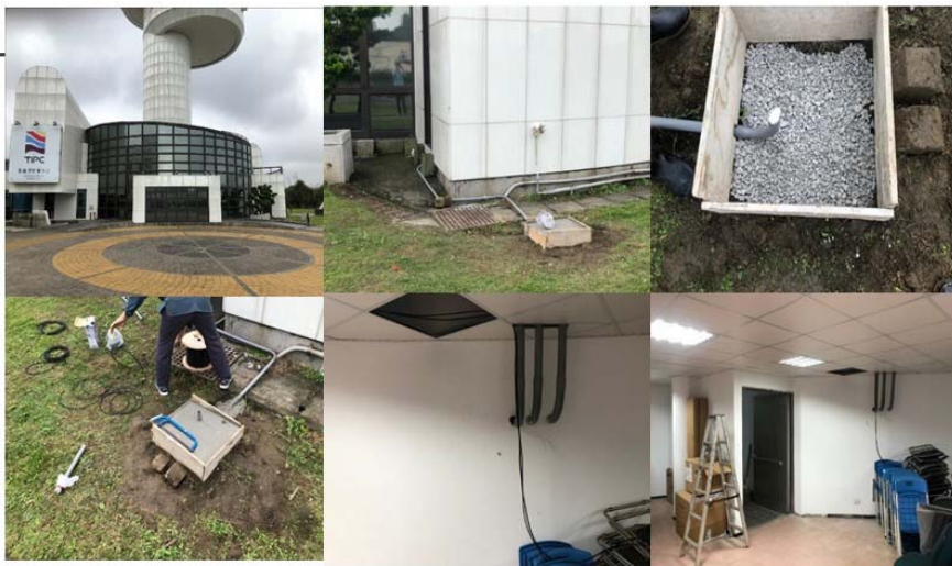
圖3-1基隆港航管中心裝設地震監測設備第1階段施工過程 18
