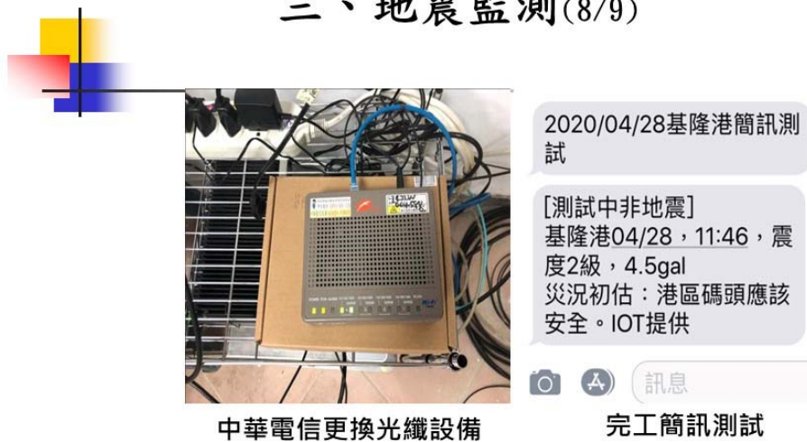
圖3-3航管中心裝設地震監測設備第3階段施工過程
