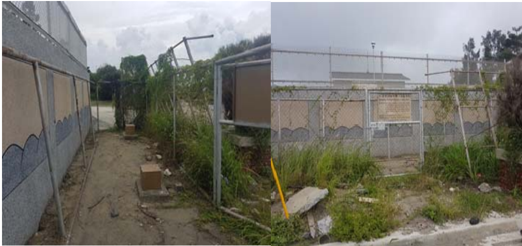
圖 3.3 布袋港 200m 監測站現場圍籬損壞情形
