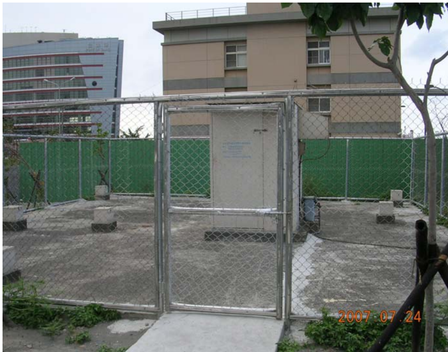
圖 2.10 臺北港區井下地震監測站
