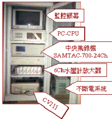
圖 2.2 機房及設備外觀示意圖
