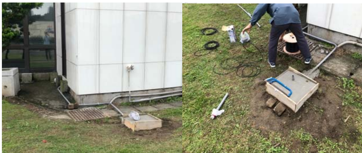
圖 3.7 室外固定管線、防水處理及水泥台灌製情形
