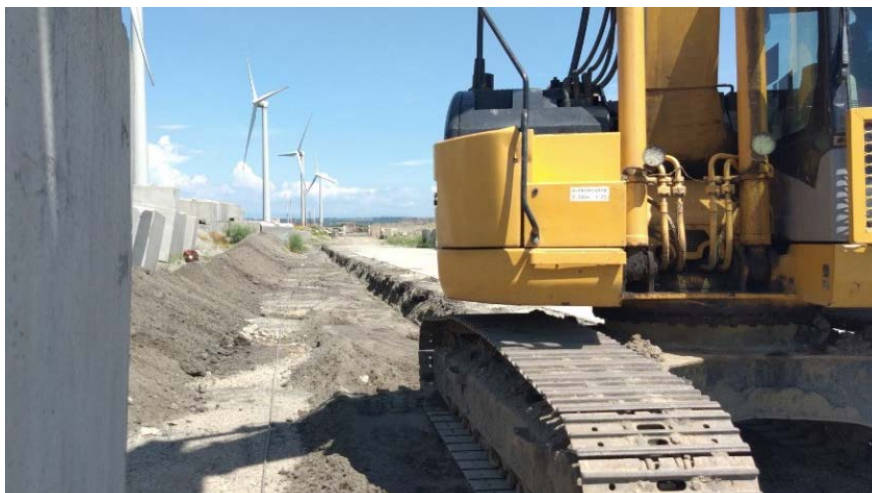
圖 3.20 北防沙堤管溝開挖
