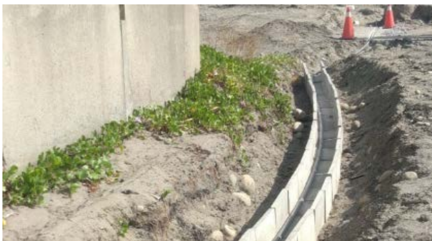
圖 3.22 排水溝鋪設
