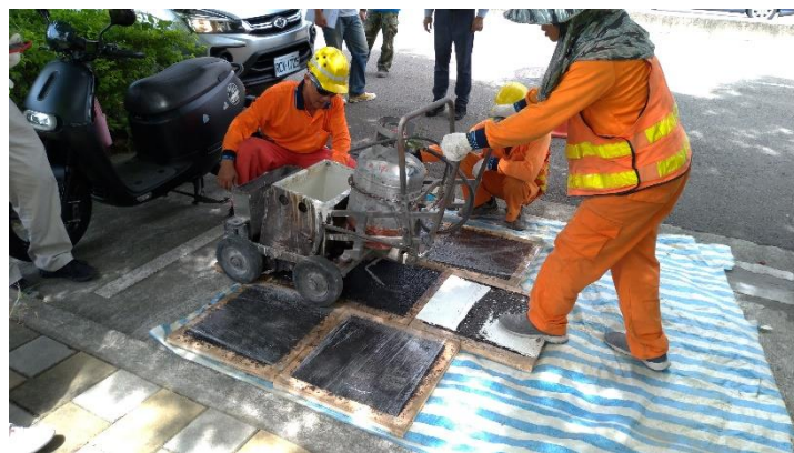
圖 42 現地標線取樣劃設作業
