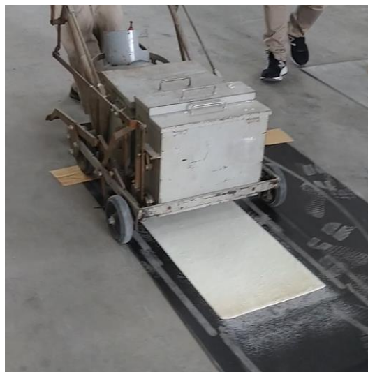
圖 38 該工廠在劃設前先將標線劃設於瀝青紙上確認品質
