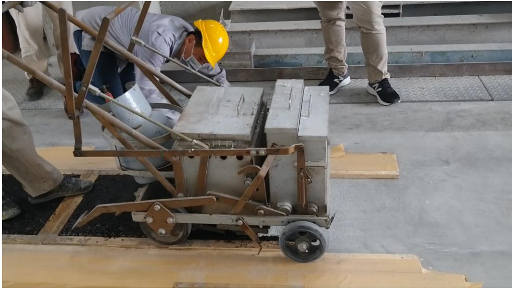
圖 39 進行劃設時另一位人員在旁確認劃設位置正確
