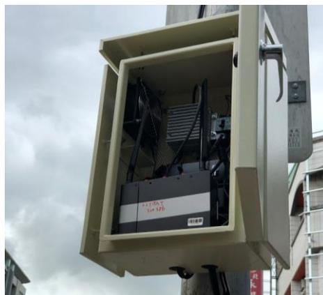
圖 3.2.3 偵測設備主機及通訊模組箱體畫面
