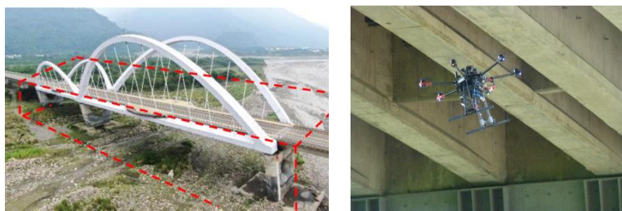
圖 2.2-22 黑客松橋檢檢測區域示意；整合示範計畫橋檢畫面
