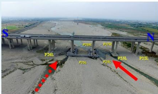
106保護工佈設及河道情形
