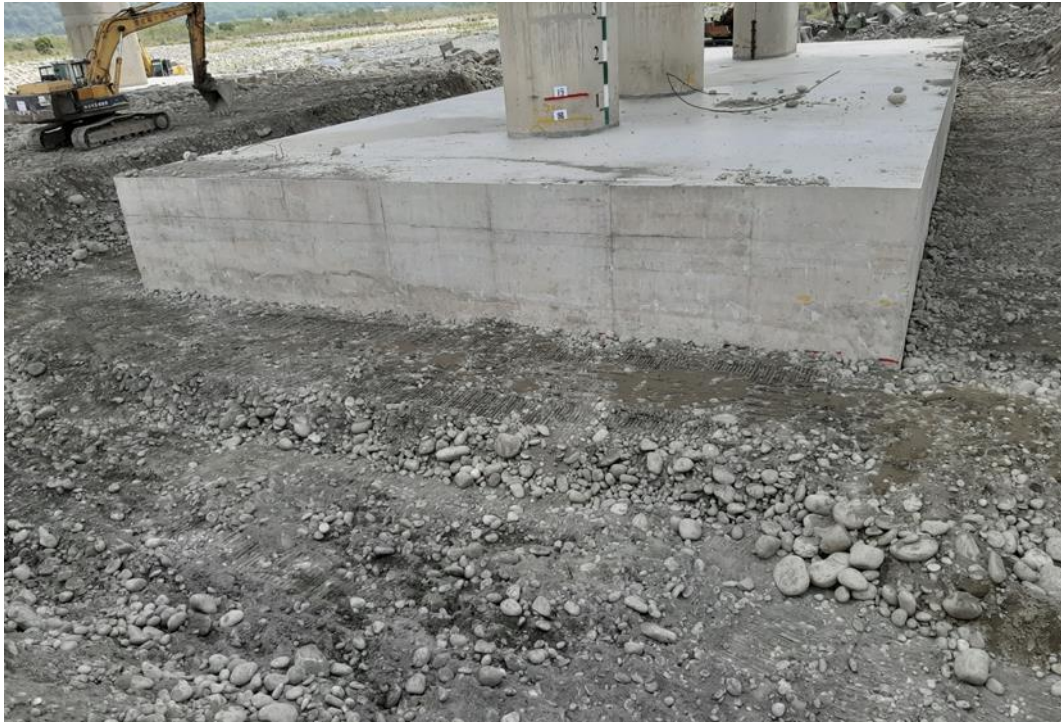
圖 2.27 橋墩基礎下游整地及地形降階
