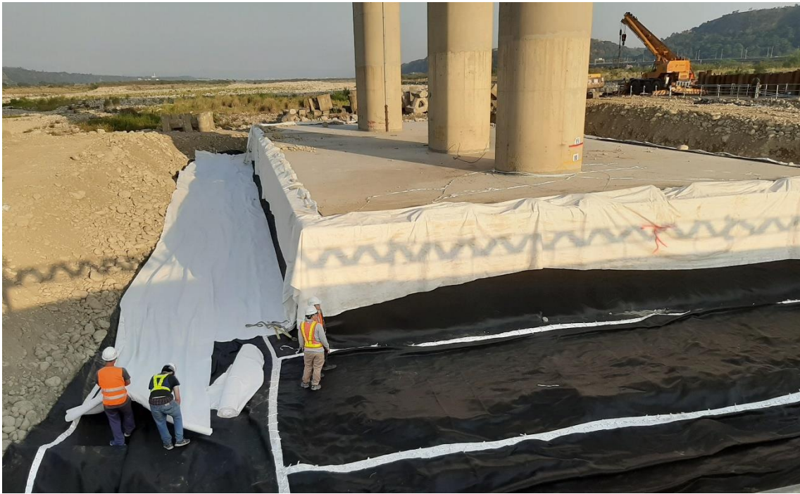
圖 2.31 防護層織布鋪設
