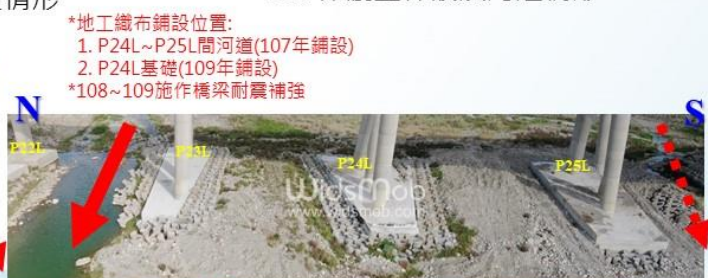
110保護工佈設及河道情形
