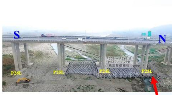
107保護工佈設及河道情形
