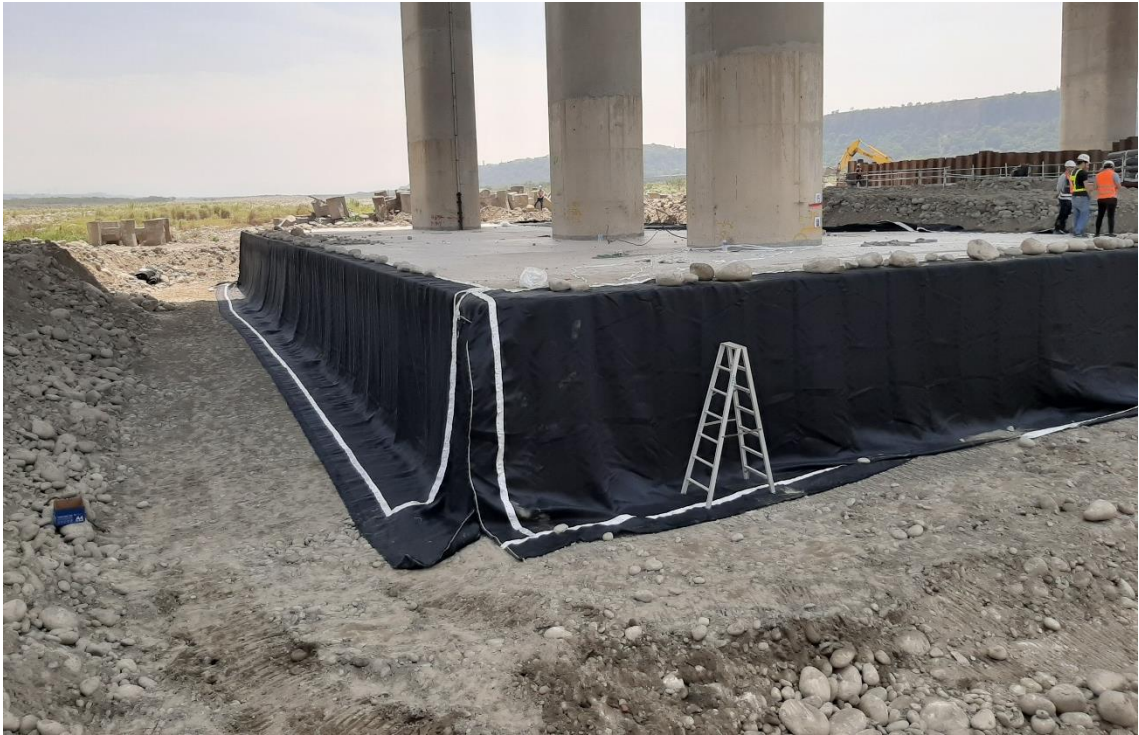
圖 2.29 完成樁帽 4 周之高強度織布吊放展開及固定
