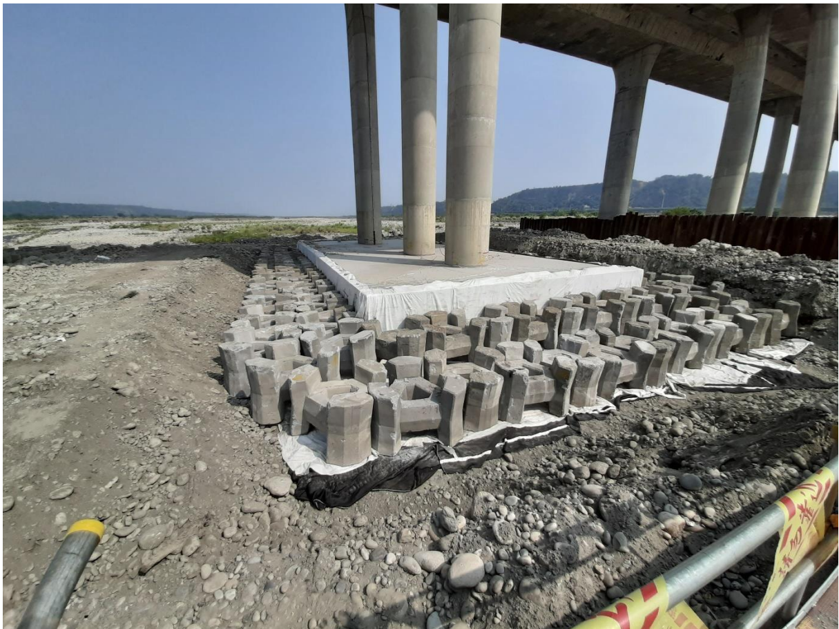
圖 3.5 國道三號大甲溪橋 P24L,P27R 地工織布保護工鋪設完工圖
