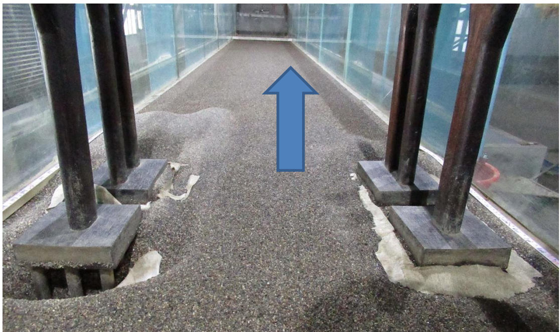
圖 6.30 埋設織布圍繞橋墩基礎保護方案沖刷情形
