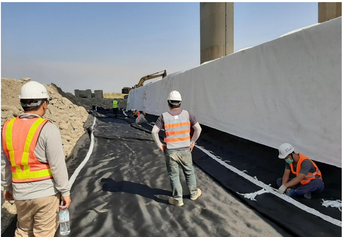
圖 2.30 平面高強度織布鋪設及單元間之綁紮作業
