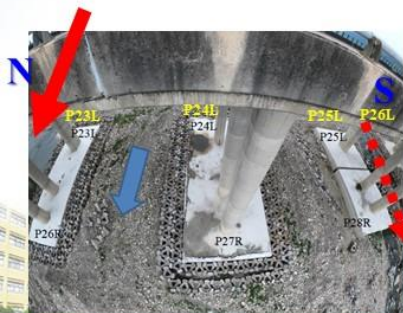
109保護工佈設及河道情形
