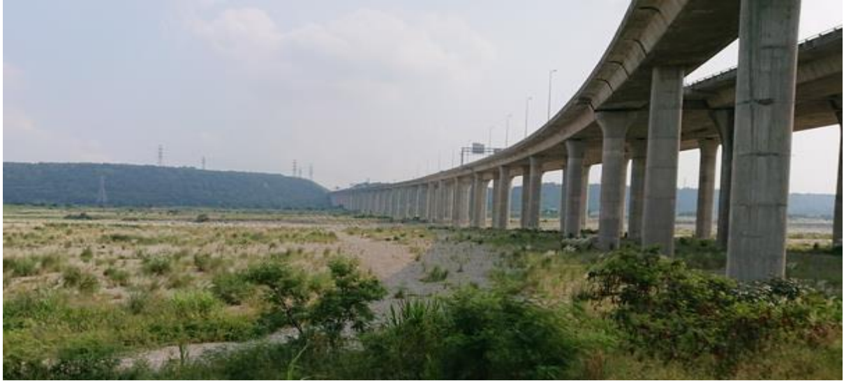
圖 3.2 國道三號大甲溪橋現況
