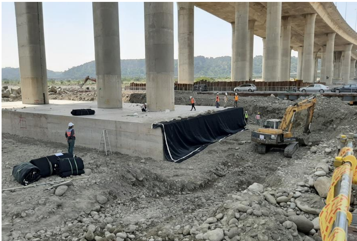
圖 2.28 高強度織布展開並以軟石固定於樁帽上
