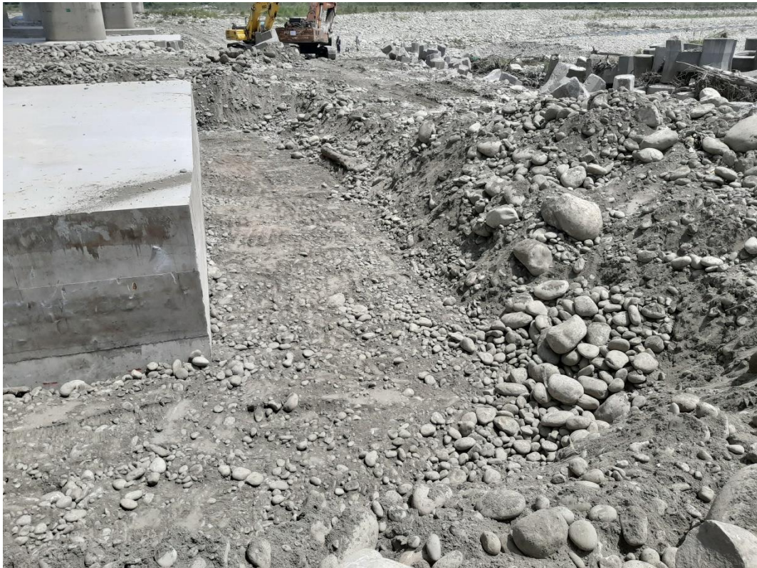
圖 2.26 橋墩基礎上游整地
