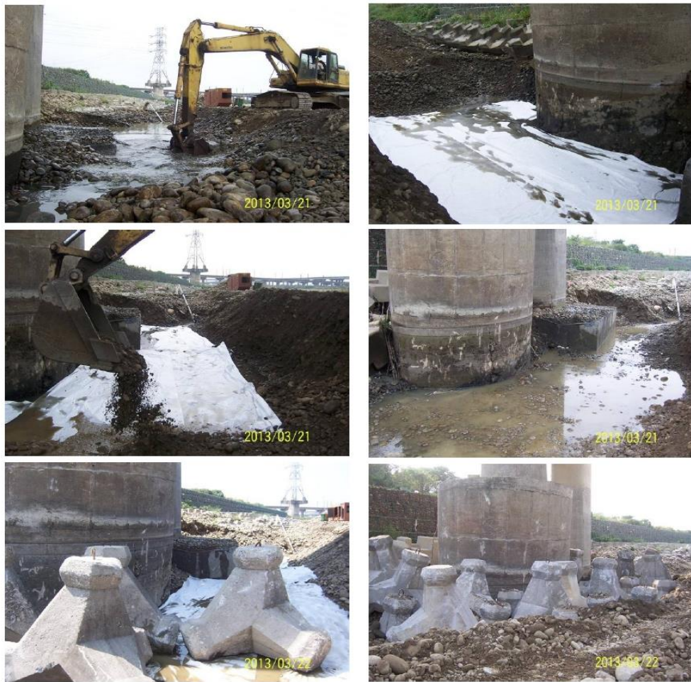
圖 2.11 保護工施工程序
