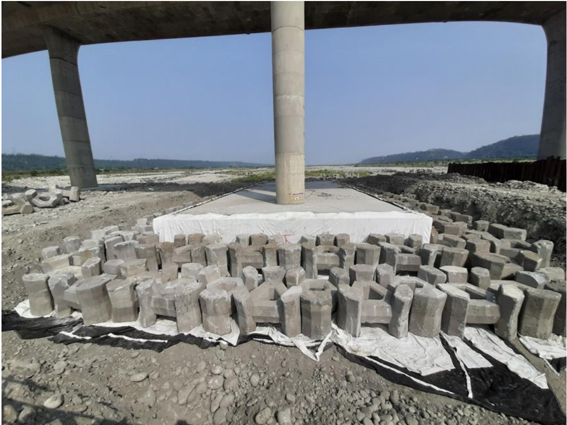
圖 2.33 鼎型塊結合地工織布保護工鋪設完成(下游側)
