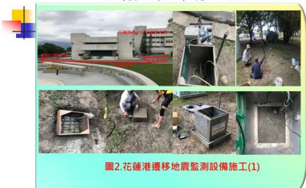
圖2.花蓮港遷移地震監測設備施工(1)
