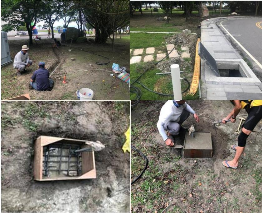
圖 3.6 花蓮港地震設備第 1 階段施工圖
