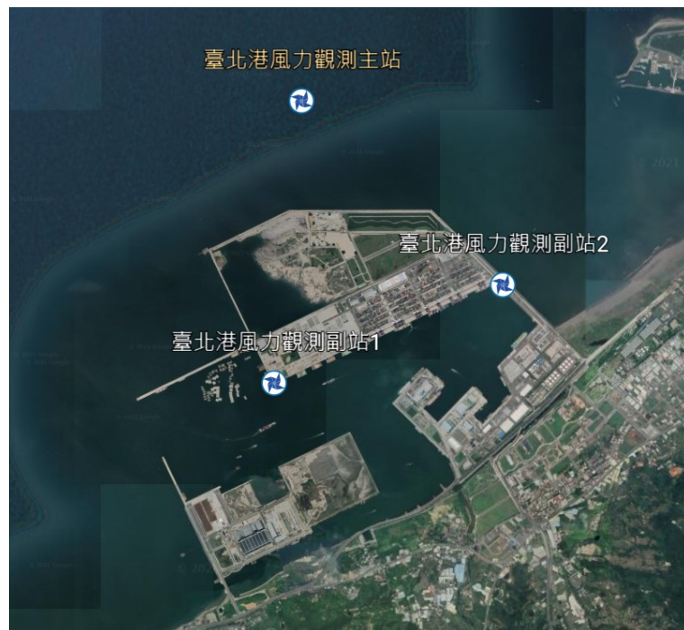
圖 1.9 臺北港主副風力測站位置圖
