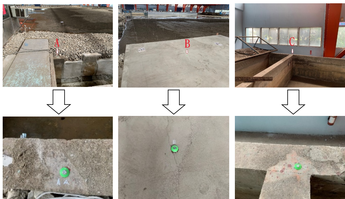
圖 6 水工模型控制點測量情形
