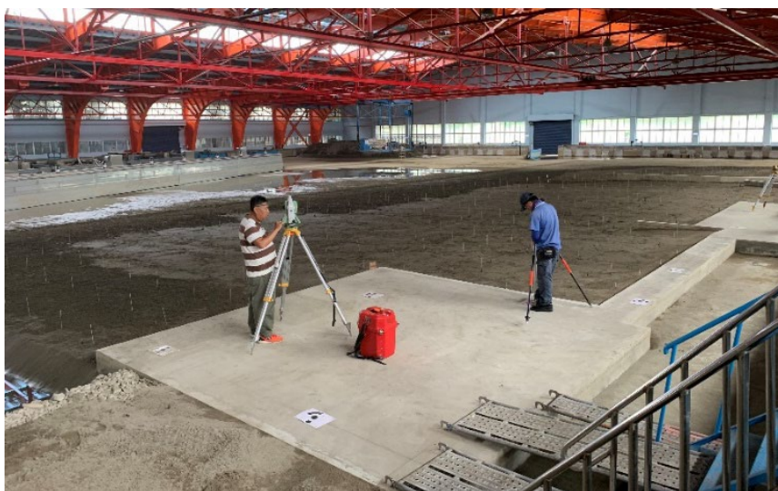
圖 4 控制測量情形
