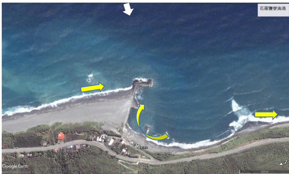
鹽寮漁港_GoogleEarth_細平_突堤效應_2013_04 優. jpg
