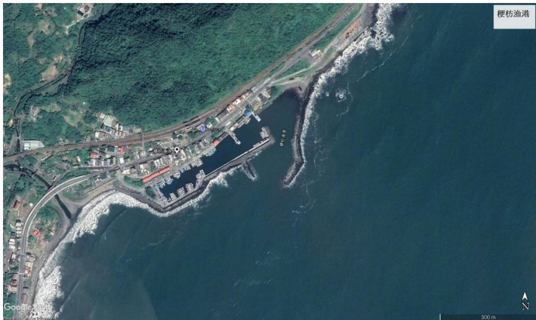
梗枋漁港_GoogleEarth_小_2018_10 優. jpg
