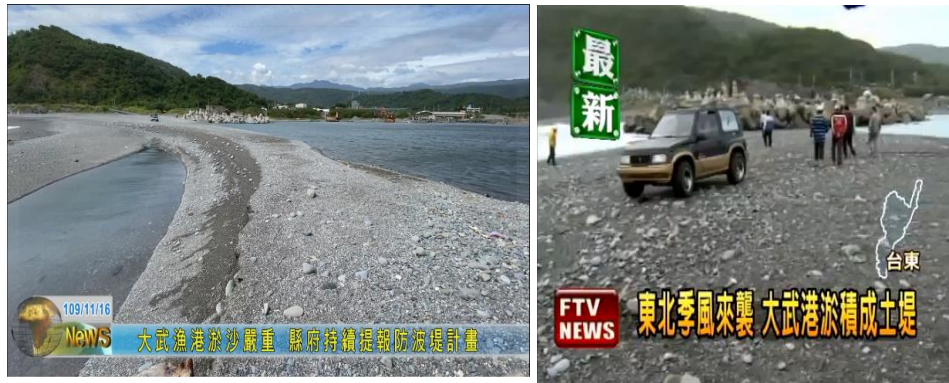
圖 4-2 臺東大武漁港淤塞於港口灘面(左)及港嘴(右)之大粒徑卵石
