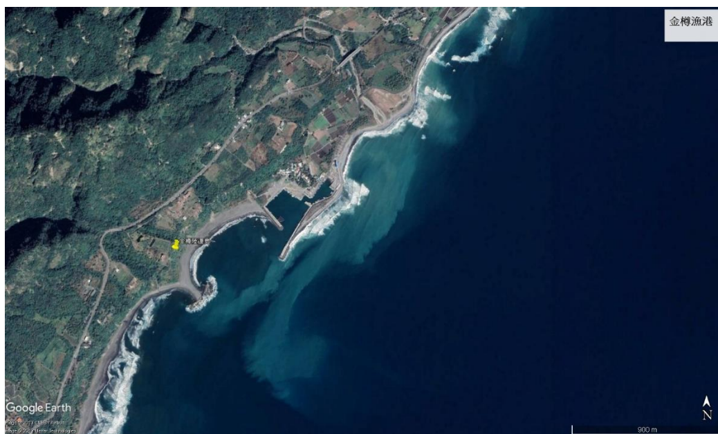
金樽漁港_陸連島_google_20181006_中.jpg
