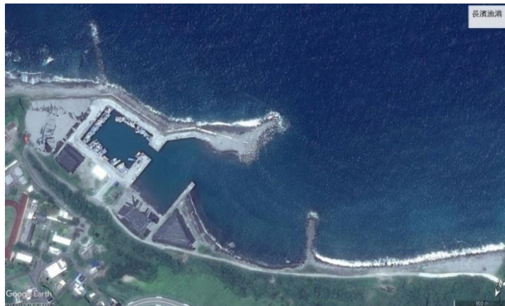
長濱漁港_離岸堤效應_港口細平 20130627. jpg
