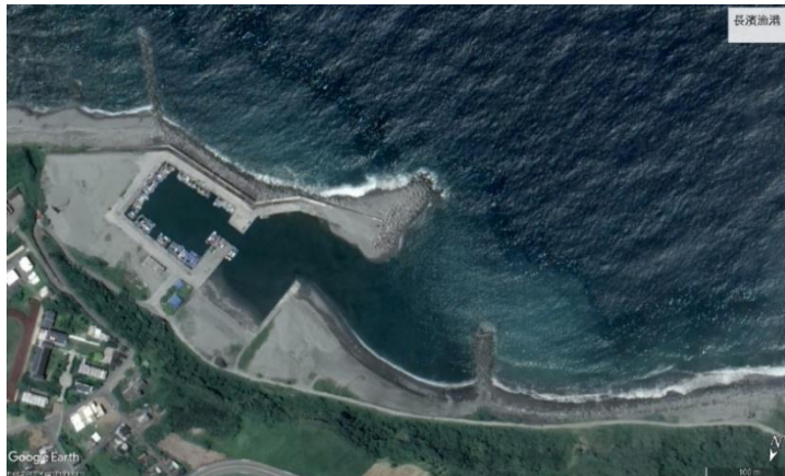
長濱漁港_離岸堤效應_港口細平 20170706. jpg
