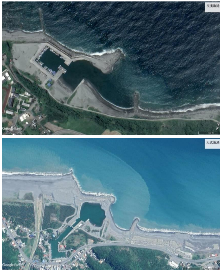
圖 1-8 臺東海岸長濱漁港(上，2017/07)及大武漁港(下，2018/12)因「離岸堤效應」造成繫岸沙洲型態的港口淤塞與毗鄰海灘之沖蝕
