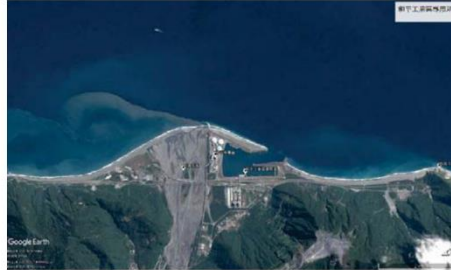
和平工業區專用港_Google Earth_中平_2013_11優.jpg
