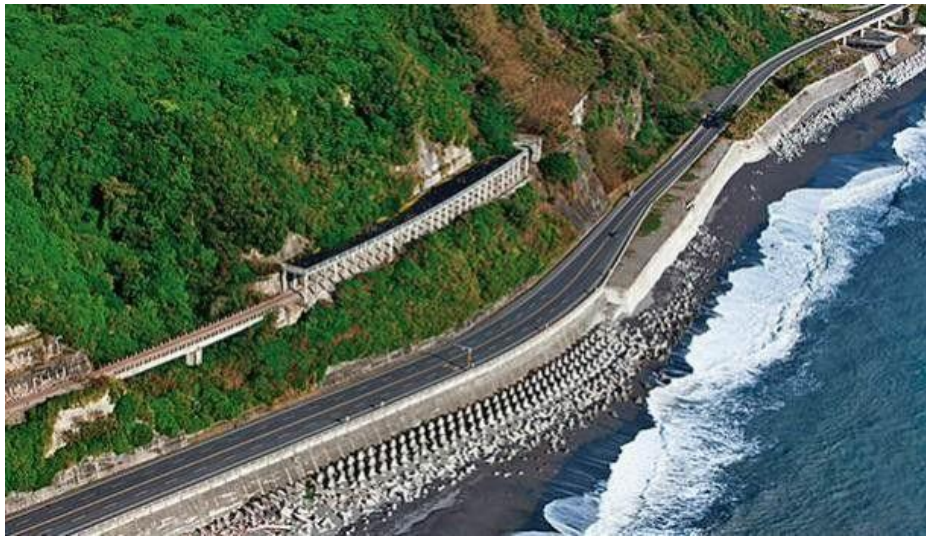
圖 1-4 臺灣東部侵蝕嚴重並用大量消波塊保護的海岸公路
