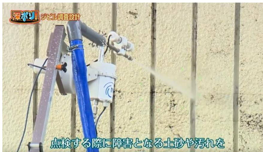
圖 2.21 高壓水柱清除髒污
