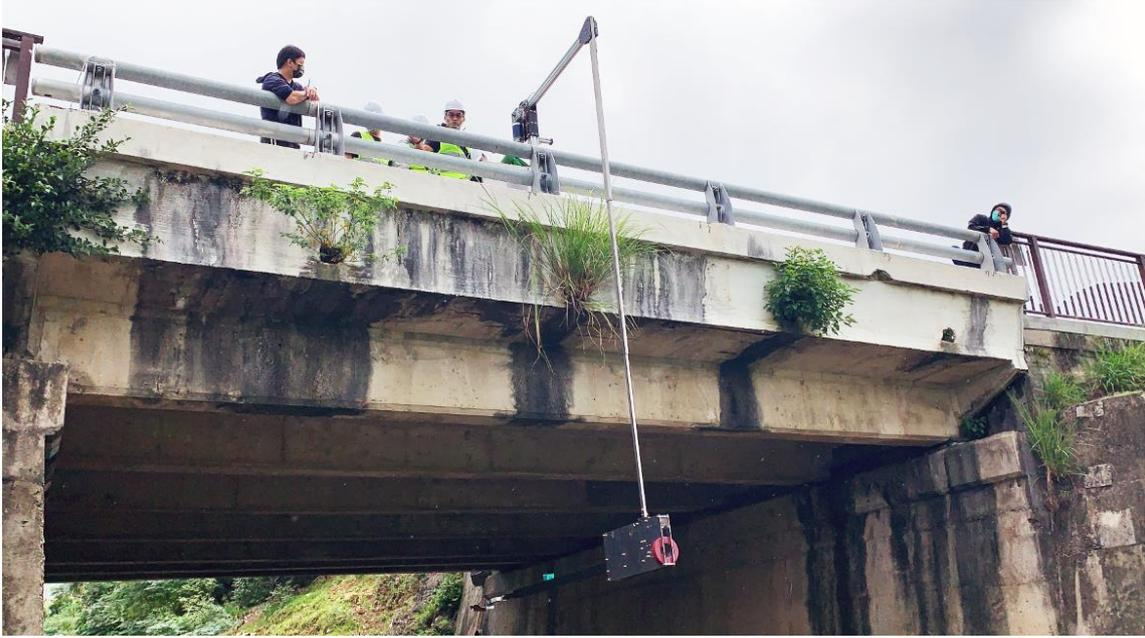
圖 4.13 C 桿轉正進入待量測狀態
