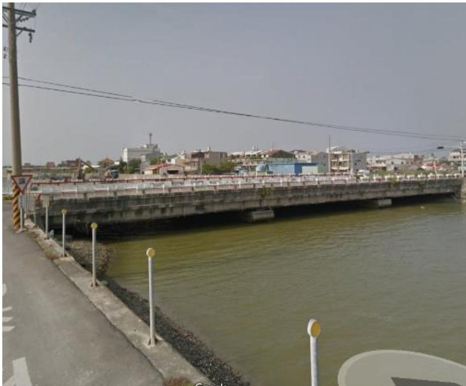
圖 1.2 鯤鯓橋橋梁底座及橋墩長期浸在河中
