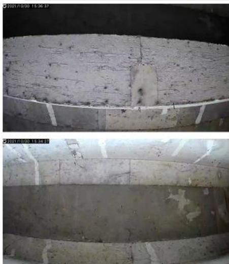
本次量測影像如左圖所示，設備控制C桿末端攝影機以步進方式移動，當主體移動至定位後，C桿以步進方式每次移動約60cm伸入梁底取得影像，當伸長至最長後收回，設備本體前進約50cm，重複伸長C桿取得下一區段影像。
