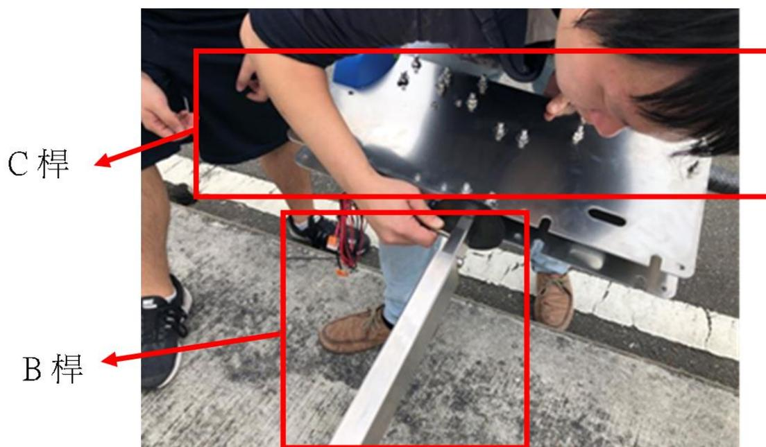
圖 2.60 利用插銷將 C 桿固定於 B 桿末端
