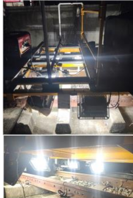
軌道扣件巡檢3.0 - 精進
