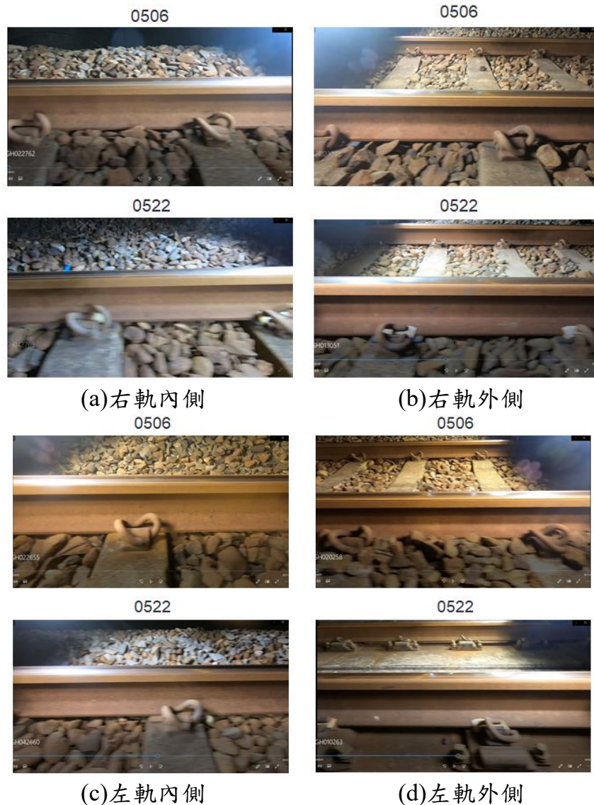
圖 4.3 第三代平車 v1 版之側向軌道構件攝影結果
