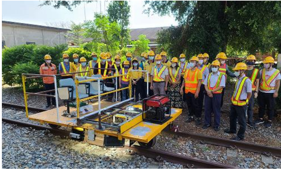
(a) 解說平車設備安裝情形
