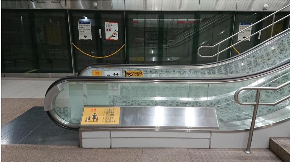
圖 5.21 捷運營運機構 C-切除電扶梯下乘場平行地面欄杆
