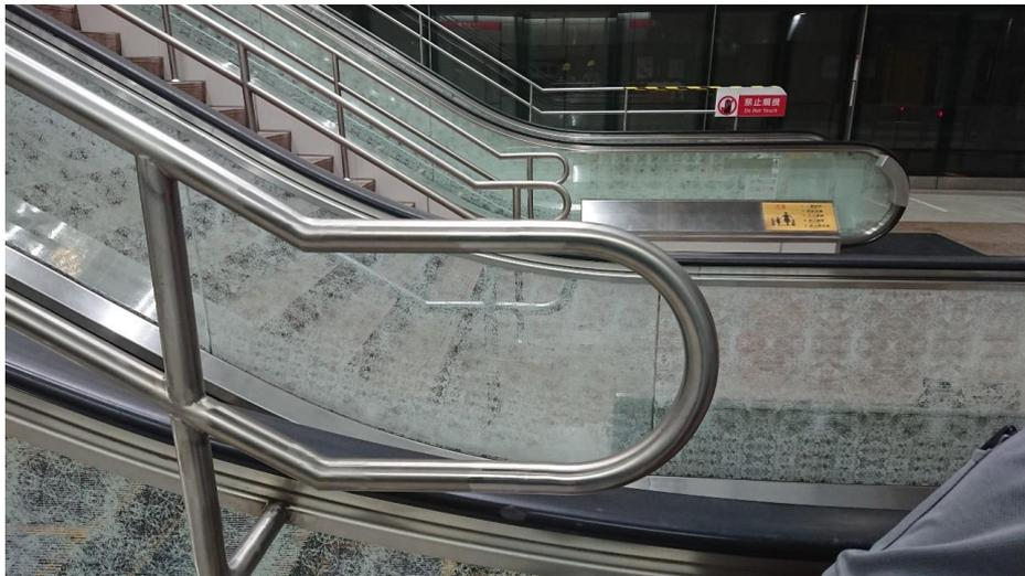
圖 5.20 捷運營運機構 C-電扶梯防墜護欄加掛警示牌
