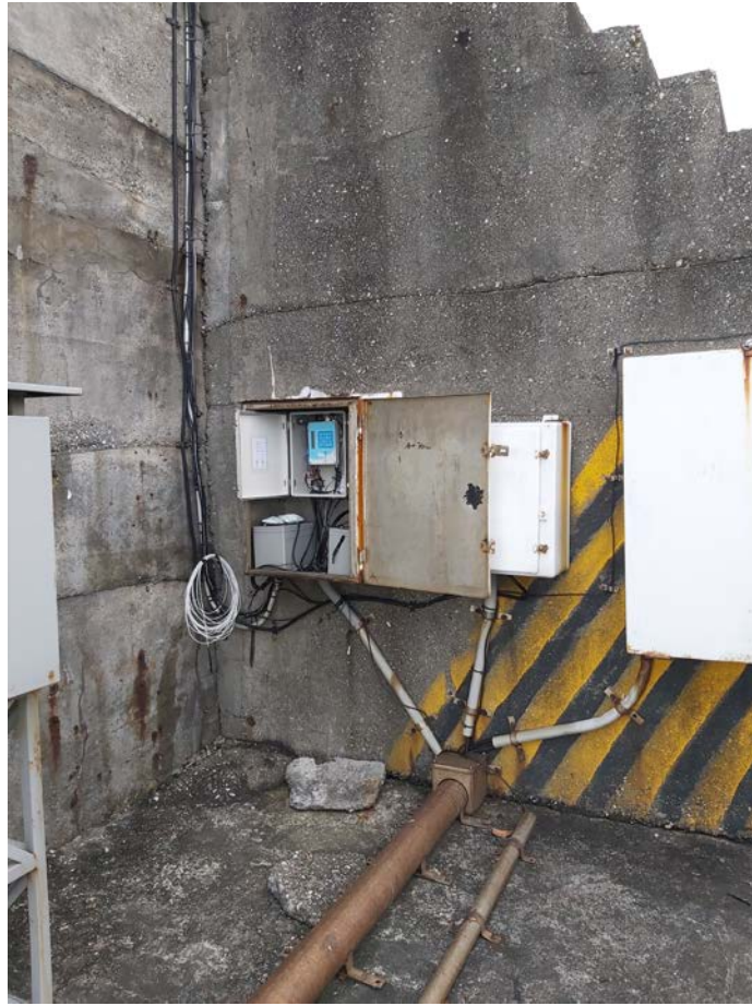
圖 5.2 花蓮港潮汐測站照片
