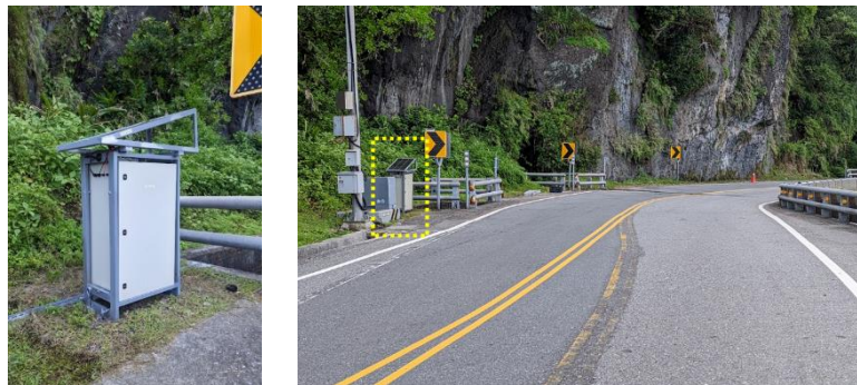
圖 3.4 花蓮縣台 11 線人定勝天路段溯升觀測站之中繼站設置圖
