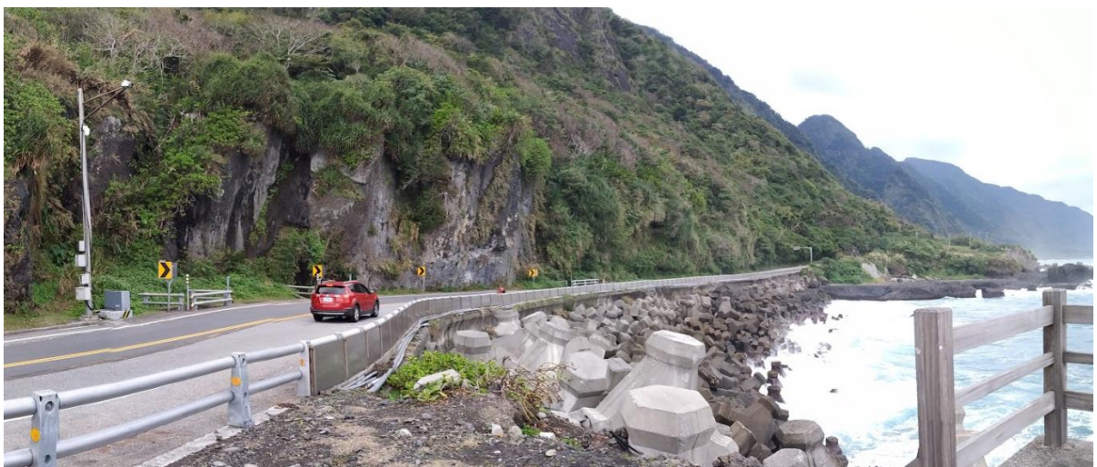
圖 3.1 台 11 線人定勝天路段海岸斷面現況 (攝於 2021/12/27)
