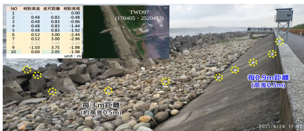
圖 2.16 高雄市彌陀區彌陀海堤堤面溯升觀測站配置概況
