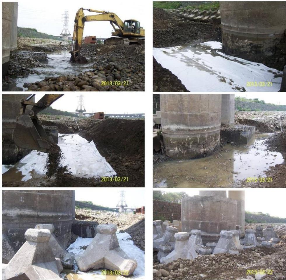
圖 2.11 保護工施工程序
