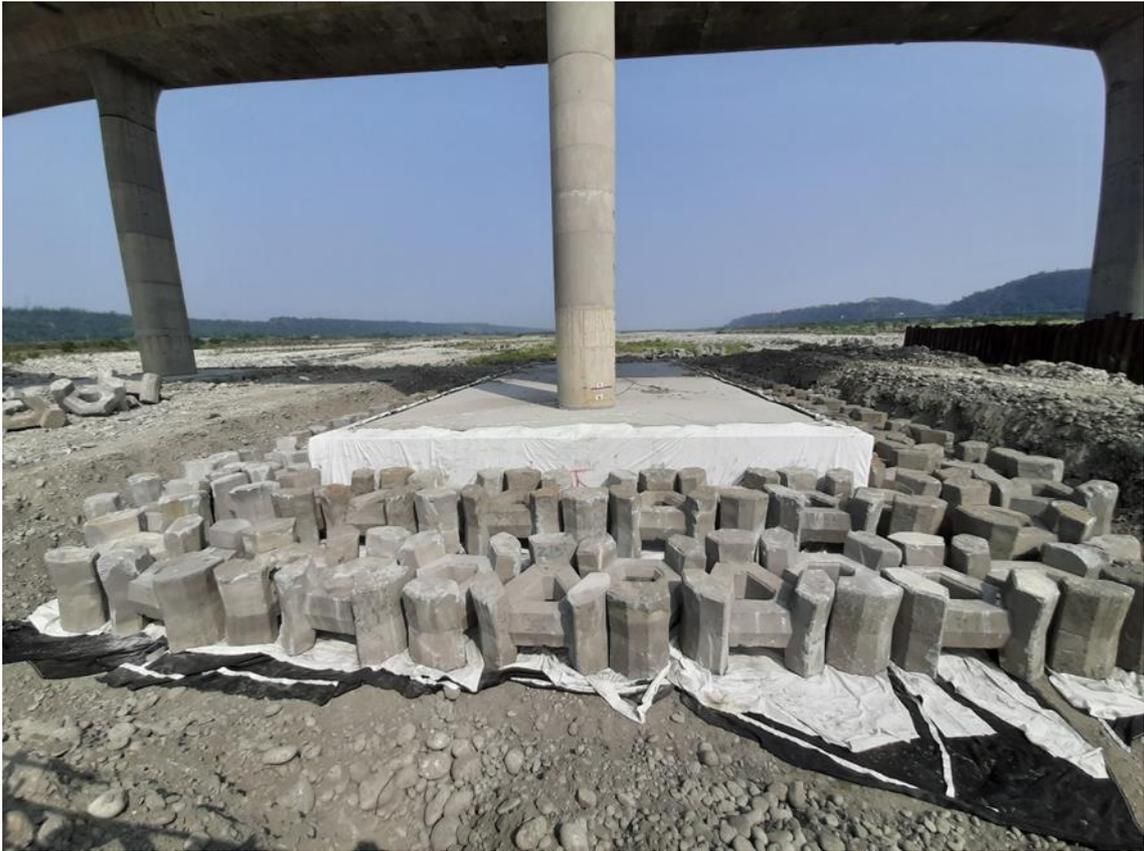
圖 2.33 鼎型塊結合土工織布保護工鋪設完成(下游側)
