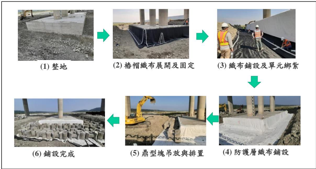
圖 3.12 鼎型塊織布橋基保護工法施工流程
