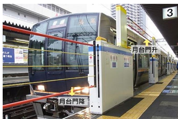
圖 2.7 JR 西日本公司採用昇降繩索搭配伸縮桿型式之月台門
