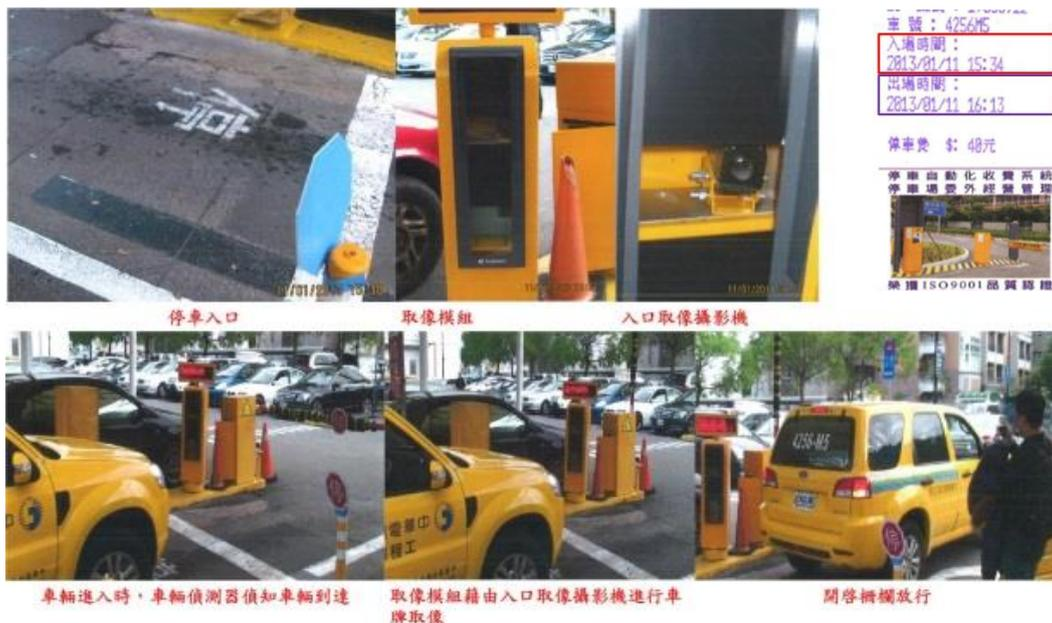
一種無票式停車場收費系統，係車輛進入時，車輛偵測器偵知車輛到達，隨即由取像模組藉由入口取像攝影機進行車牌取像，並記錄到達時間，而後開啓柵欄放行；
