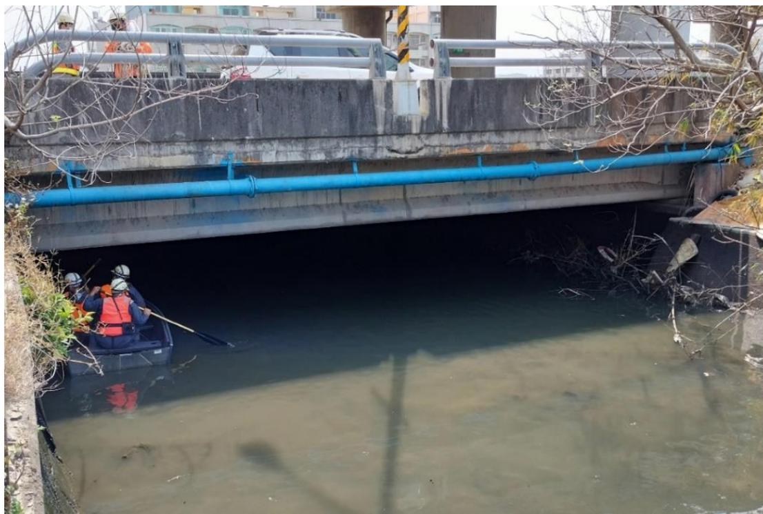
圖1 橋檢人員乘坐船艇進入橋梁底部勘查檢測
