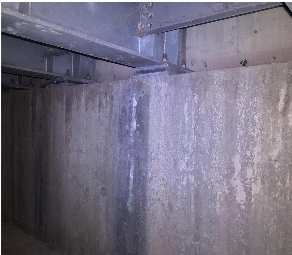
圖4 檢測工具側向拍攝支承、帽梁影像
