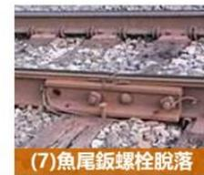
本所110年軌道構件缺失辨識系統之**螺栓與扣件辨識項目**
