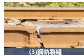
本所110年軌道構件缺失辨識系統之**鋼軌辨識**項目
