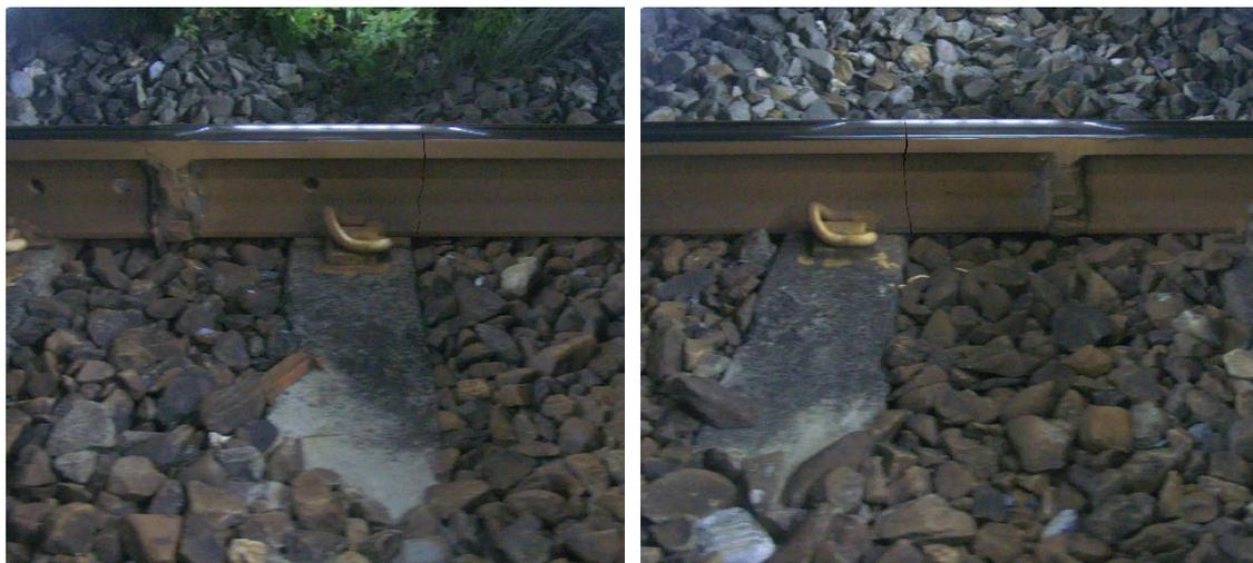
圖 4.13 合成軌腹裂縫示意圖
