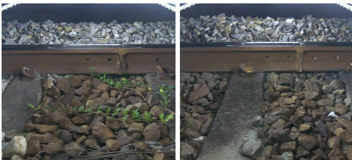
圖 4.14 合成銲接處裂縫示意圖
