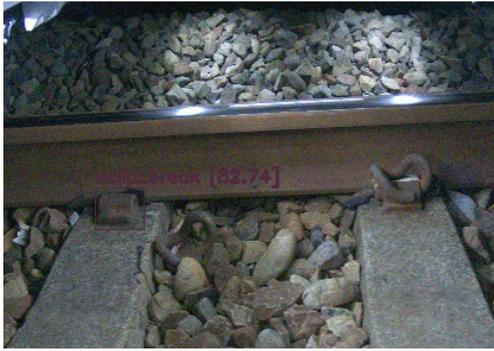
圖 4.39 第三階段臺中現地驗證檢出紀錄—e 扣夾缺失(續)
