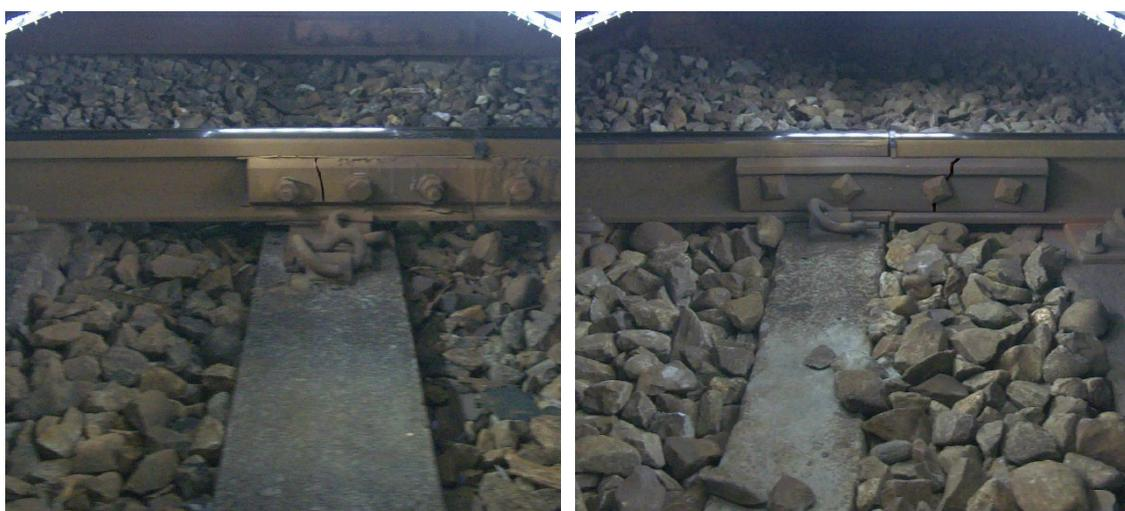
圖 4.15 合成魚尾鉸裂縫示意圖
