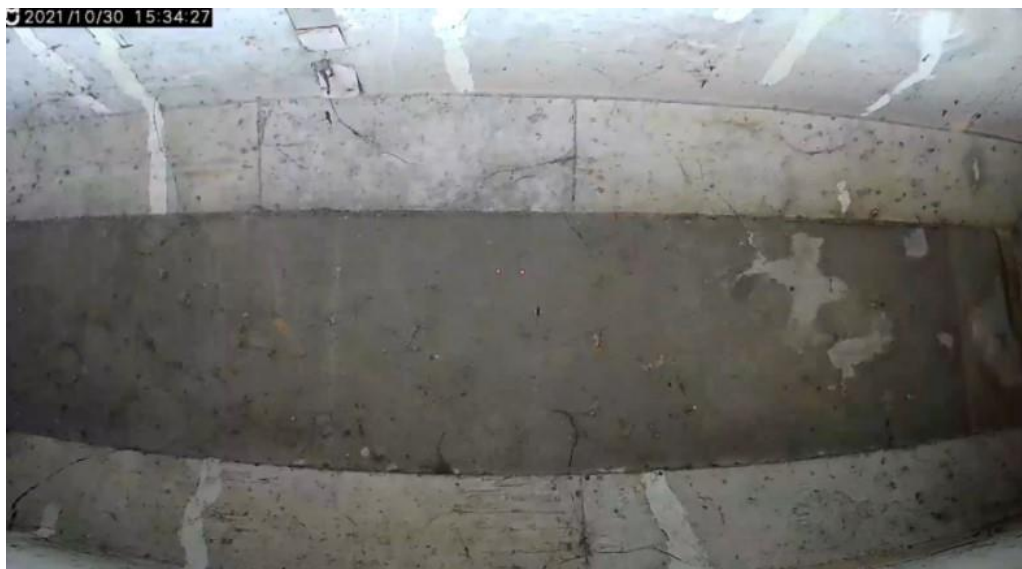
圖 2 檢測工具拍攝梁底影像
