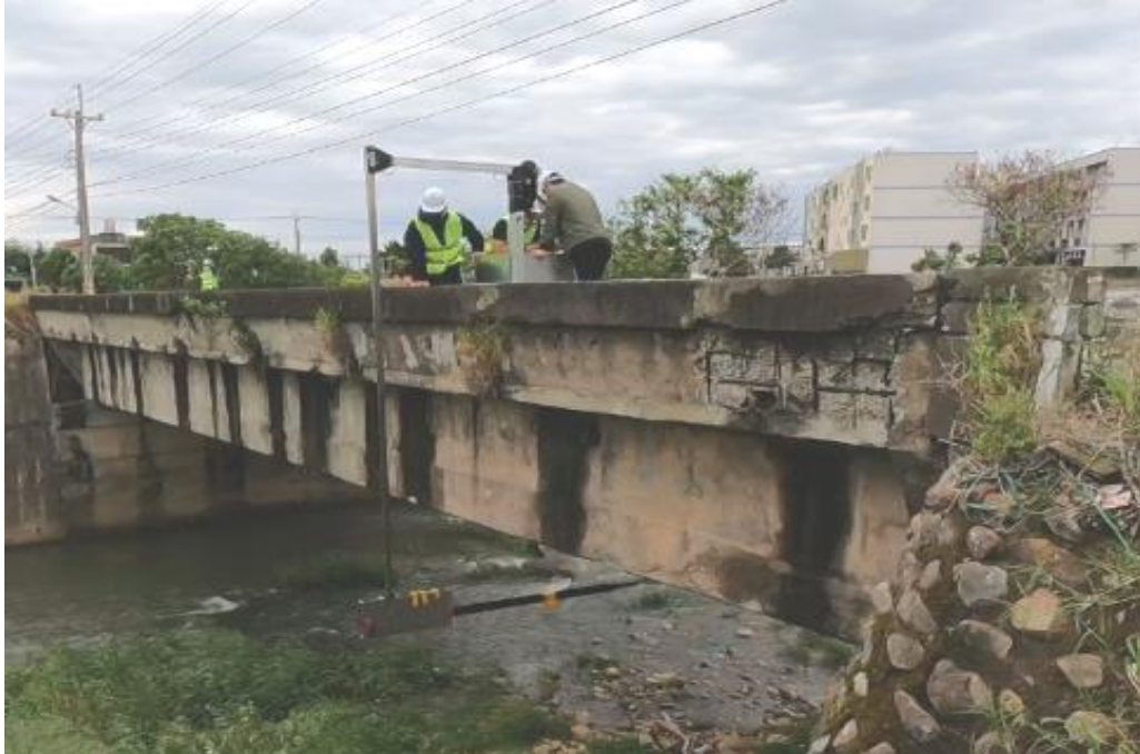
圖 1 新竹縣德河橋進行實地測試
