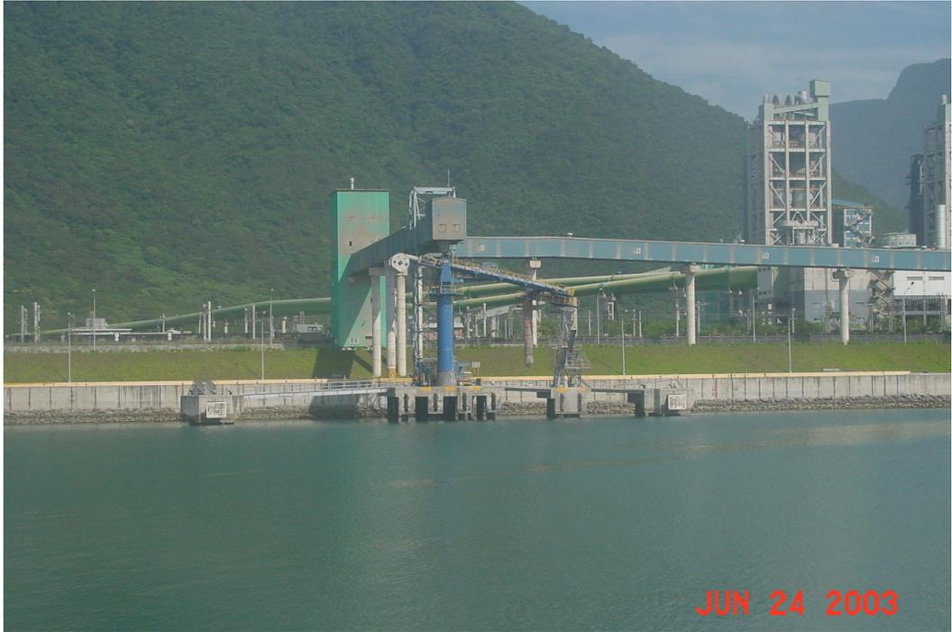
圖 5 S-3 碼頭(水泥專用碼頭，長度 220 M 水深-13.0 M)
