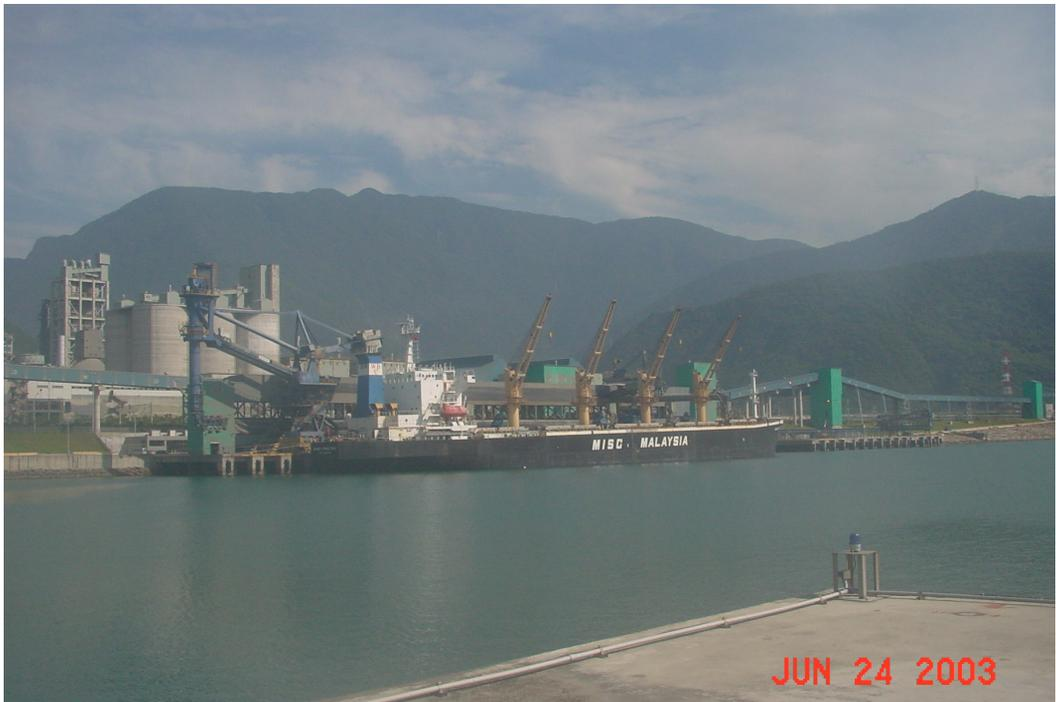
圖 4 S-2 碼頭(多用途碼頭，長度 220 M 水深-13.0 M)
