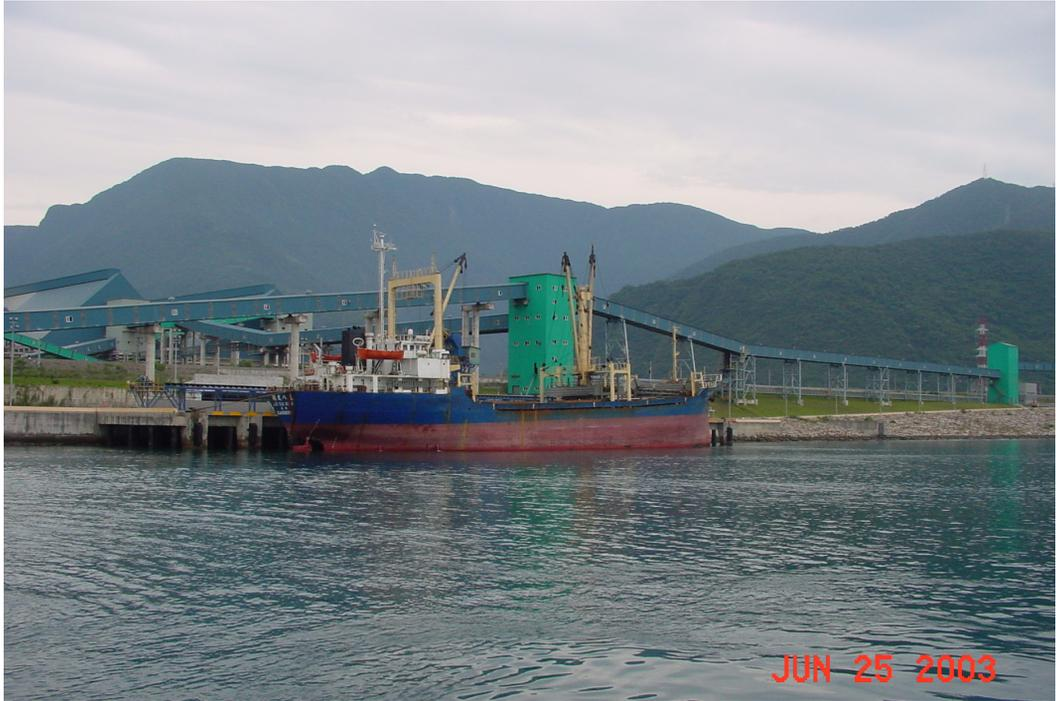
圖 3 S-1 碼頭(重件及砂石碼頭，長度 120 M 水深-9.0 M)
