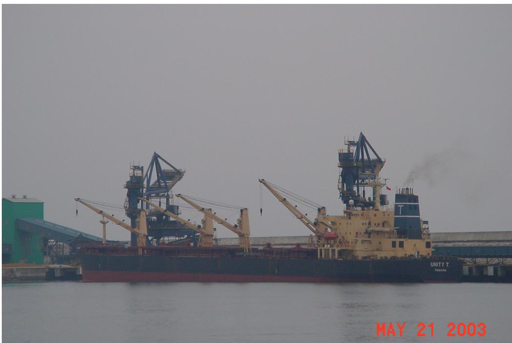
圖 2 N-2 碼頭(卸煤及砂石碼頭，長度 300 M 水深-16.0 M)
