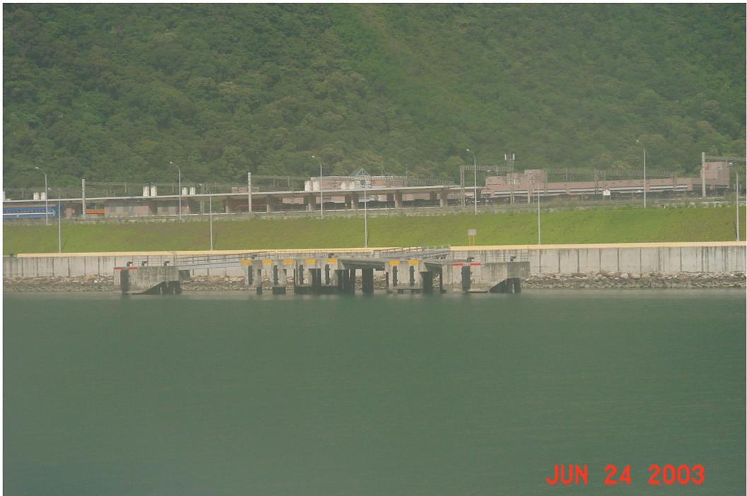
圖 6 S-4 碼頭(水泥專用碼頭，長度 200 M 水深-12.0 M)
