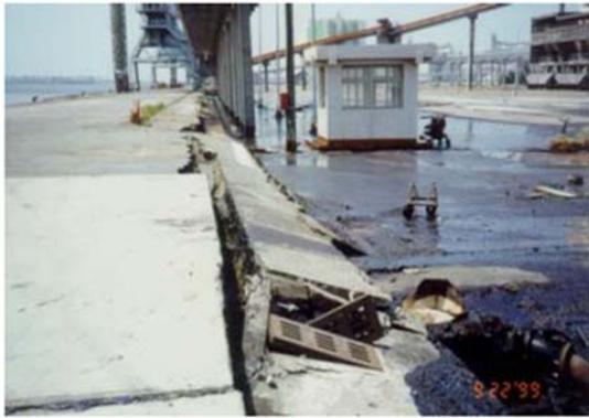
圖 3 台中港#1~4 沉箱式碼頭於 921 震後碼頭岸肩與後線高程差側視圖（運研所，2007）
