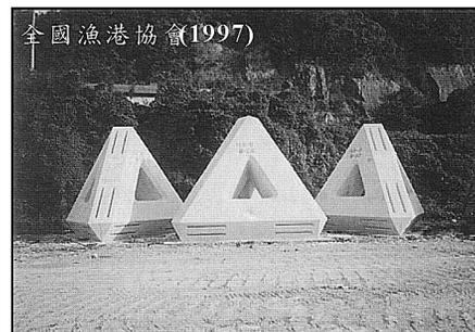
圖3 濱田漁港防波堤之生態型消波塊
