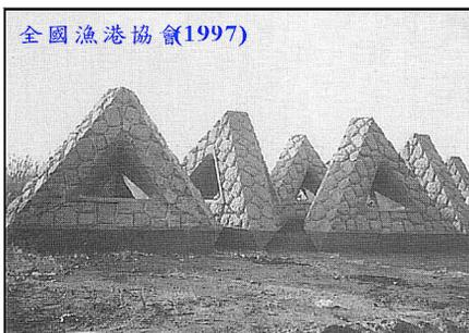
圖 6 外川漁港離岸堤之景觀型消波塊
