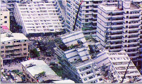
圖 3-2 台中王朝大樓 921 地震倒塌情形
