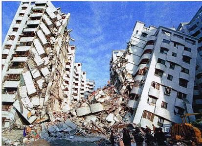
圖 3-3 台中金巴黎社區 921 地震倒塌情形
